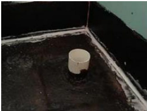
Fig.4.24 – Aplicação de pintura betuminosa e mastique de poliuretano – zona do box [27]
