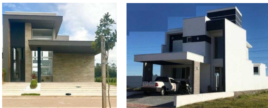
Fig.5.3 – Habitações em alvenaria de blocos executadas pela Fabrilar [33]
