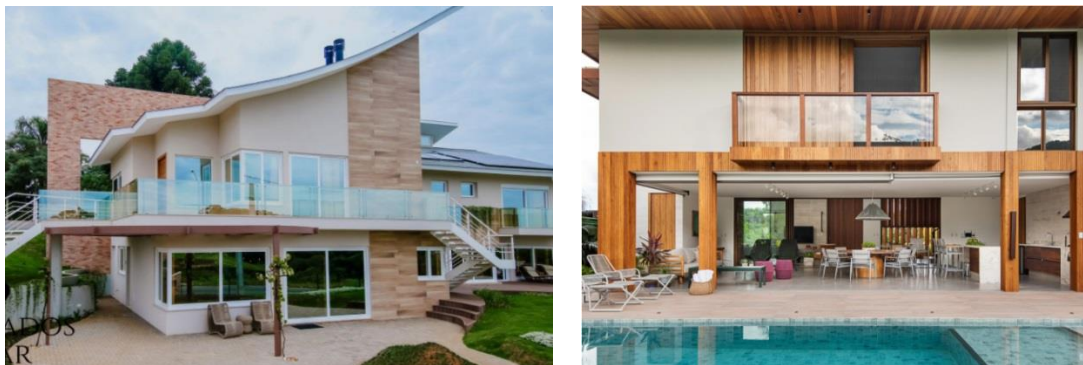
Fig.5.6 – Casas de alto padrão construídas na serra do Rio de Janeiro [34]
