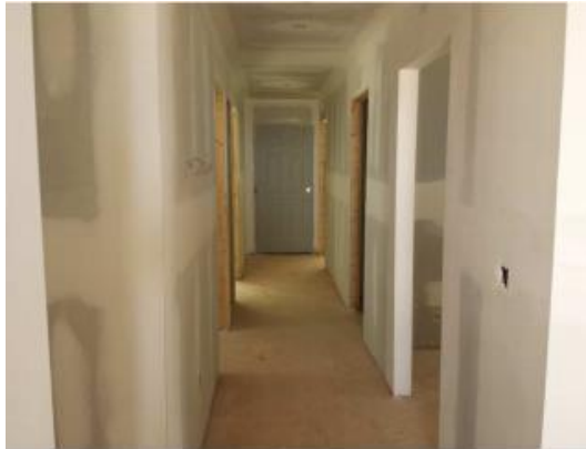
Fig.4.19 – Revestimento interno em gesso acartonado [27]
