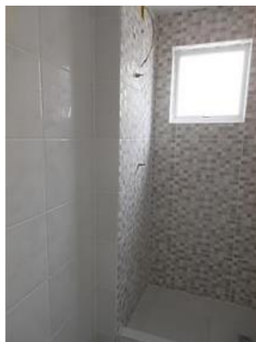
Fig.4.27 Aspecto final do revestimento cerâmico [27]
