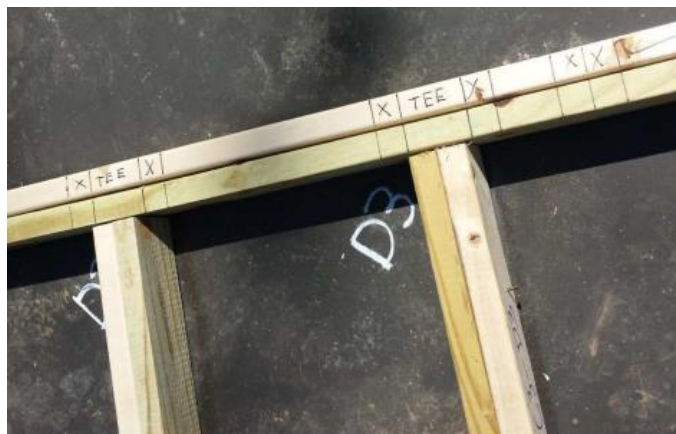
Fig.4.33 – Quadro estrutural posicionado e com marcações dos elementos verticais [27]
