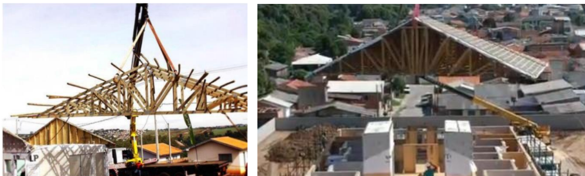
Fig.4.12 – Estrutura de madeira e içamento da cobertura pronta [27]
