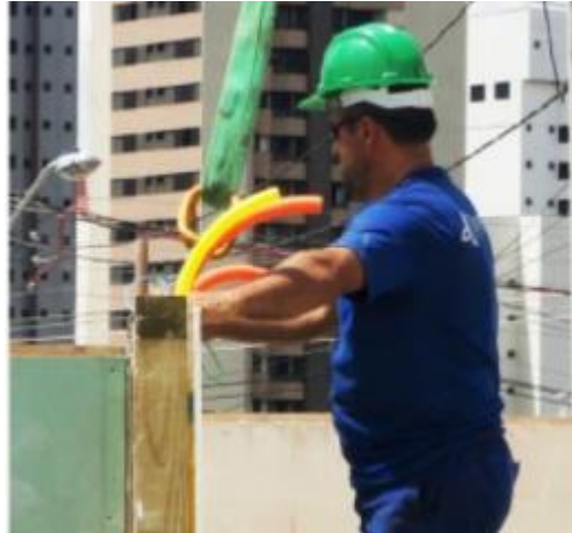
Fig.4.31 – Organização dos eletrodutos após a montagem dos painéis [27]
