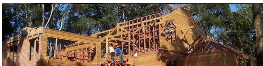
Fig.3.21 – Realização da montagem de uma casa de madeira pela empresa Wunder Haus [28]
