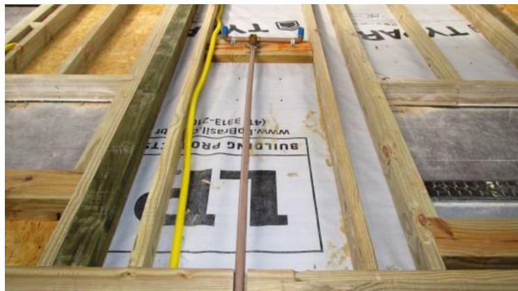
Fig.4.28 – Kit hidráulico fixado ao painel durante o processo na fábrica [27]
