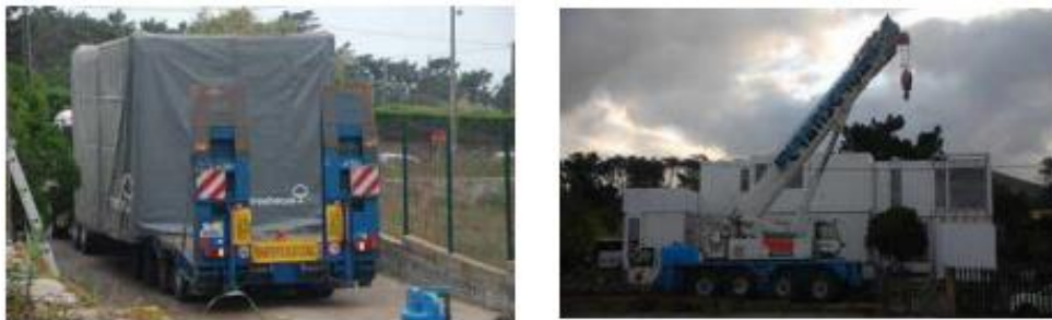
Fig.2.17 – Transporte e colocação do módulo em obra [20]
