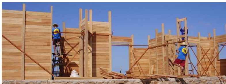
Fig.3.28 – Empresa Mamute realizando a montagem de uma casa em madeira [30]
