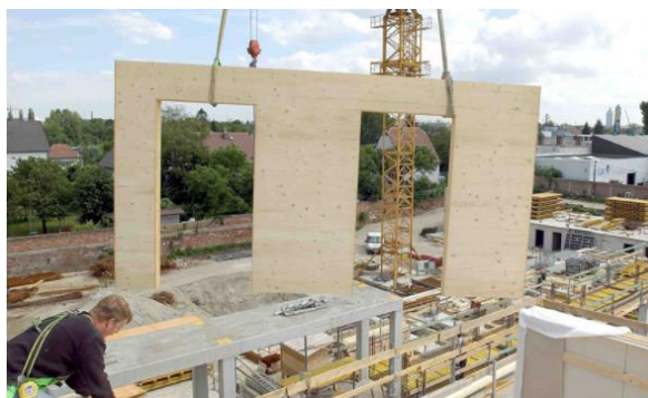
Fig.2.16 – Colocação do módulo em obra [19]
