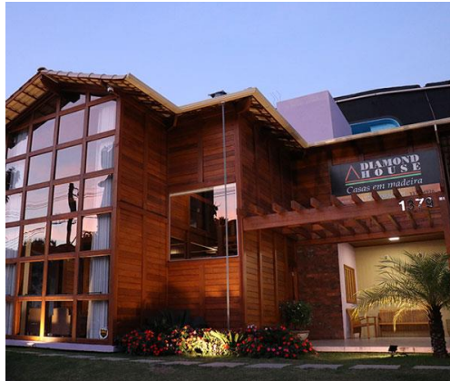
Fig.3.10 – Sede da empresa Diamond House em Minas Gerais [24]
