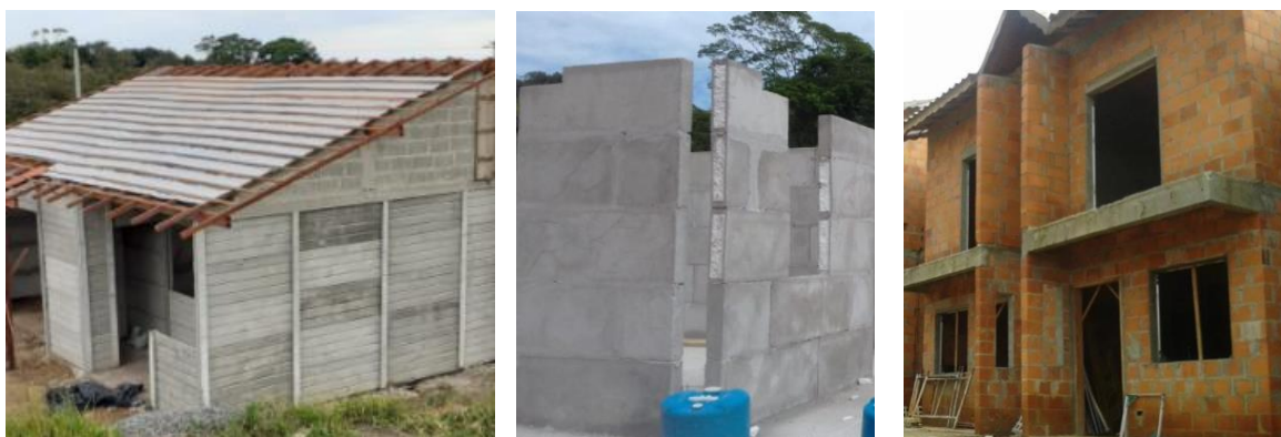
Fig.5.9 – Habitações em betão armado, blocos térmicos e blocos cerâmicos, respectivamente [36]
