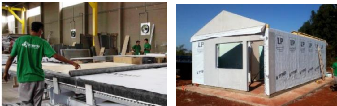
Fig.4.9 – Membrana sendo colocada sobre o painel estrutura já com OSB e o painel montado em obra [27]
