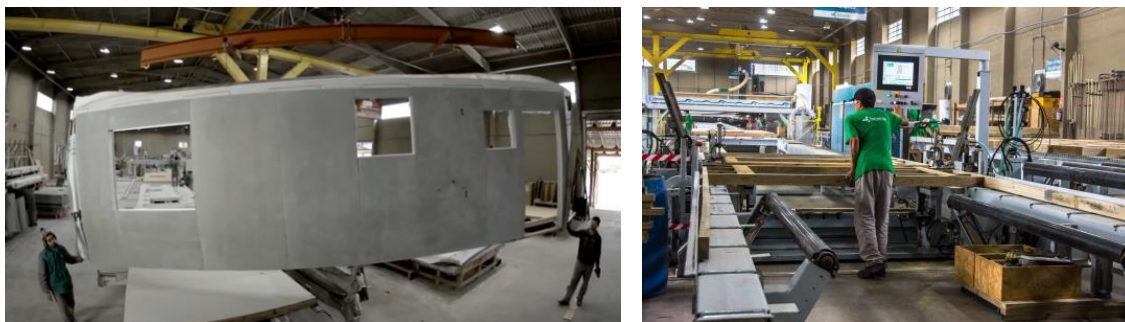
Fig.3.19 – Montagem dos painéis na fábrica da Tecverde [27]
