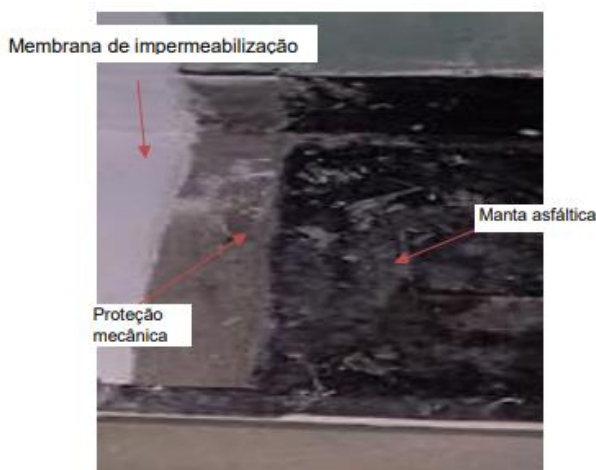
Fig.4.26 – Pormenor das camadas de impermeabilização [27]
