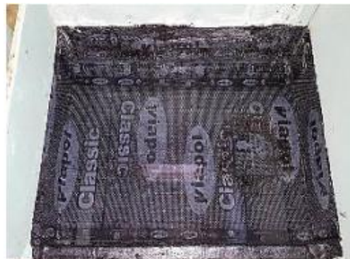
Fig.4.25 Aplicação da manta asfáltica – zona do box [27]
