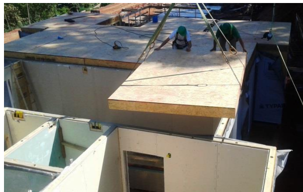
Fig.4.7 – Estrutura que irá suportar o pavimento (entrepiso) [27]
