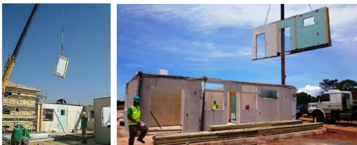
Fig.4.34 – Movimentação e montagem dos painéis de parede [27]
