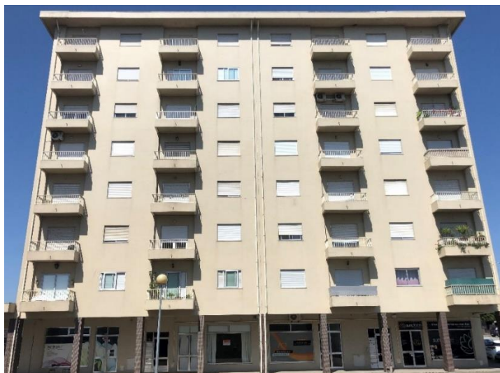
Figura 28 - Fachada principal do edifício (este)
