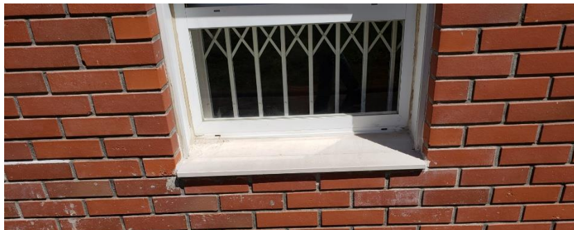
Fig. 18 Janela com caixilho simples e pedra de soleira natural
