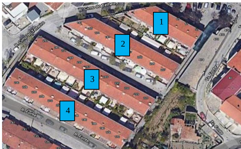
Fig. 15 Identificação do conjunto habitacional do Telheiro (fotografia retirada do google earth)
