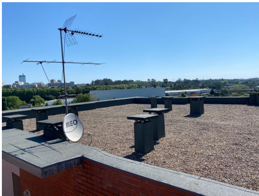
Fig. 17 Cobertura plana revestida com godó
