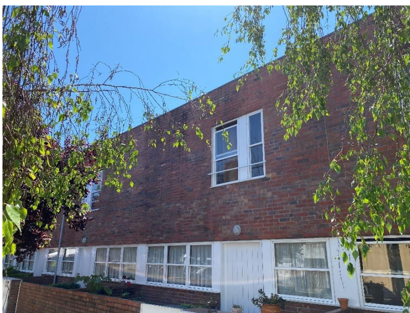
Fig. 20 Fachada de banda número 1 do Telheiro
