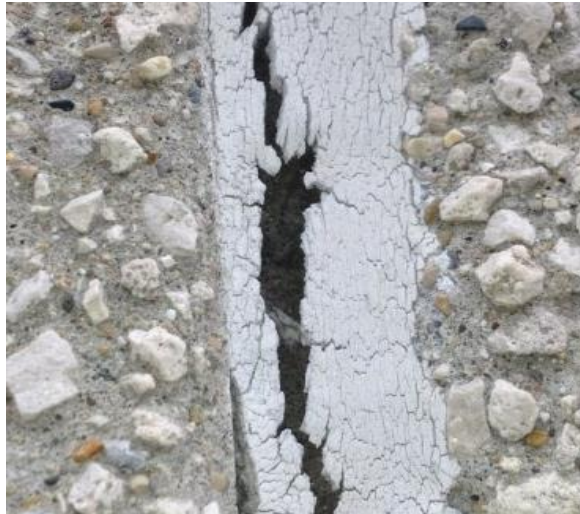
Fig. 33 Cordão de silicone envelhecido
