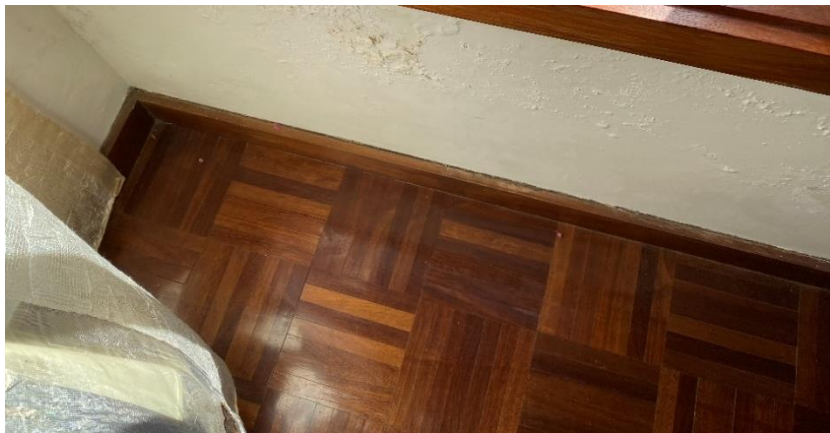
Fig. 23 Revestimento de soalho em pavimento de chão
