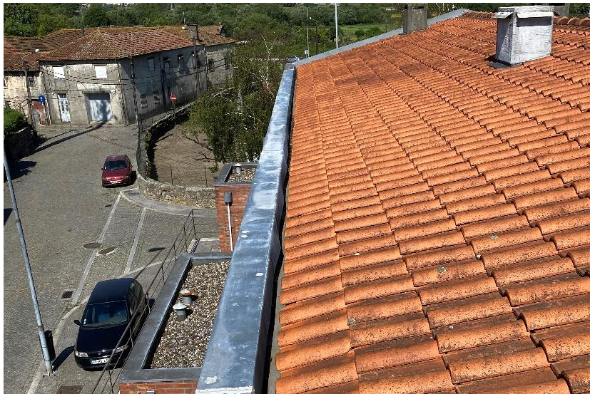
Fig. 21 Cobertura materializada em telha cerâmica
