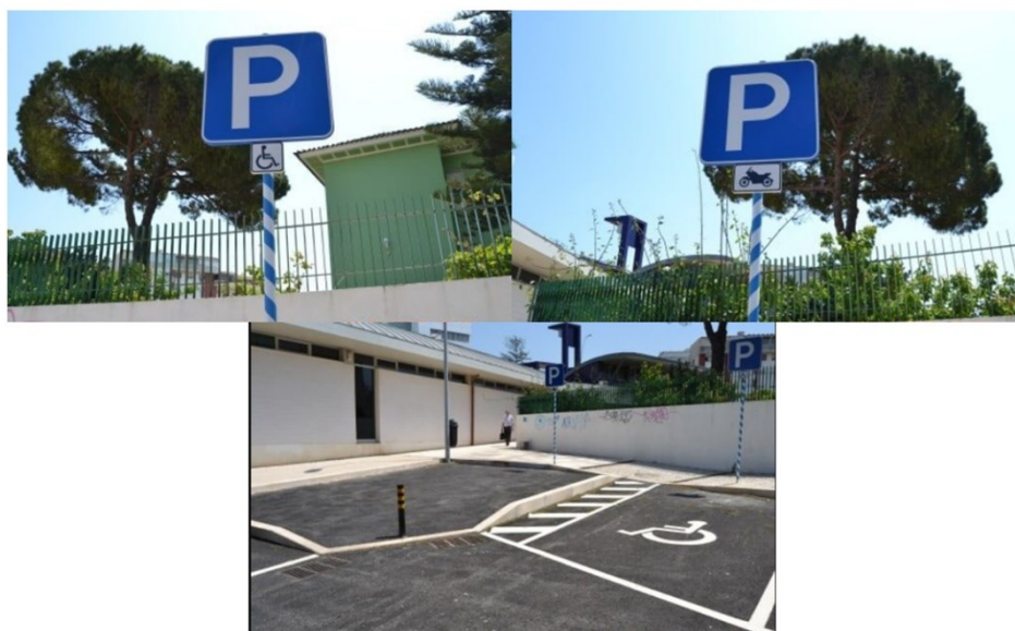
Figura 34 - Exemplo prático de sinalização vertical com adesivos cromáticos refletivos
