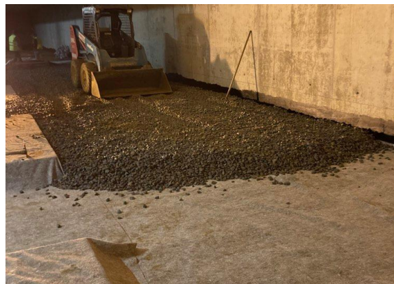
Fig. 3.8 - Espalhamento da Brita
