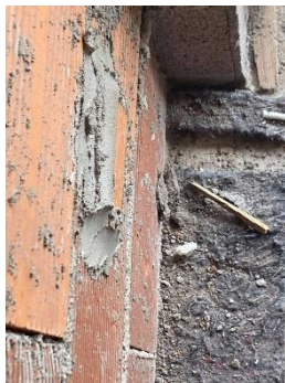
Fig. 3.17 - Ponto para orientação do reboco
