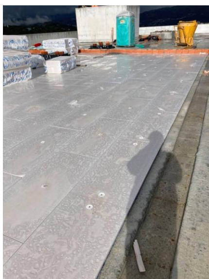
Fig. 3.15 - Isolamento da cobertura
