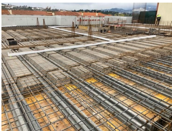
Fig. 3.6 - Cofragem da Laje
