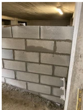
Fig. 3.11 - Alvenarias Bloco à Vista
