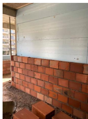
Fig. 3.14 - Isolamento da caixa de escadas
