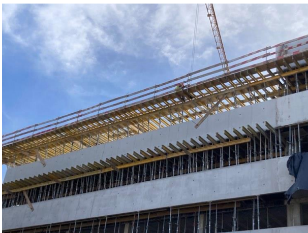
Fig. 3.3 - Estrado para suporte dos Muros Betão à Vista
