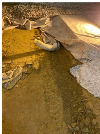
Fig. 3.7 - Colocação de tubo de dreno
