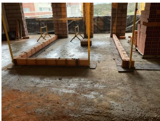
Fig. 3.9 - Marcação da Primeira Fiada
