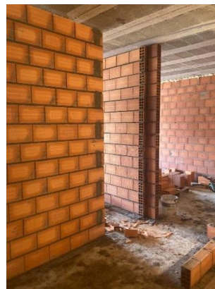
Fig. 3.10 - Alvenarias Interiores (cerâmicas)
