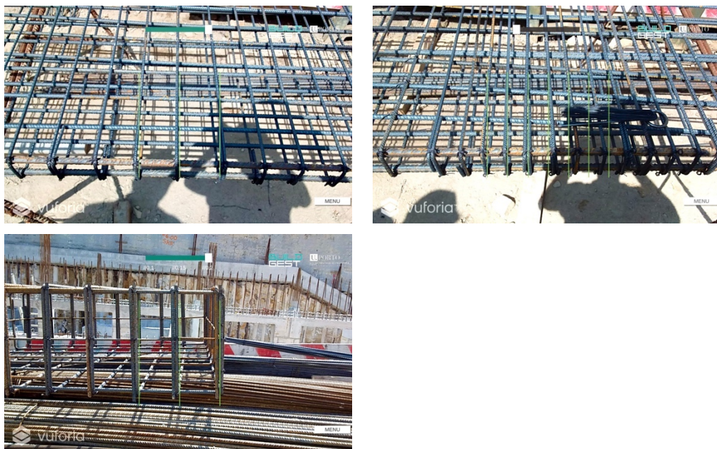
Figura 6.46 – Definição e verificação do espaçamento entre varões.
