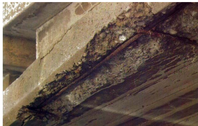
Figura 2.2 - Delaminação do betão [45]
