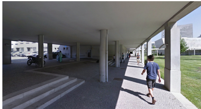
Figura 6.28 – Fotografia do aspeto real da Galeria da FEUP.
