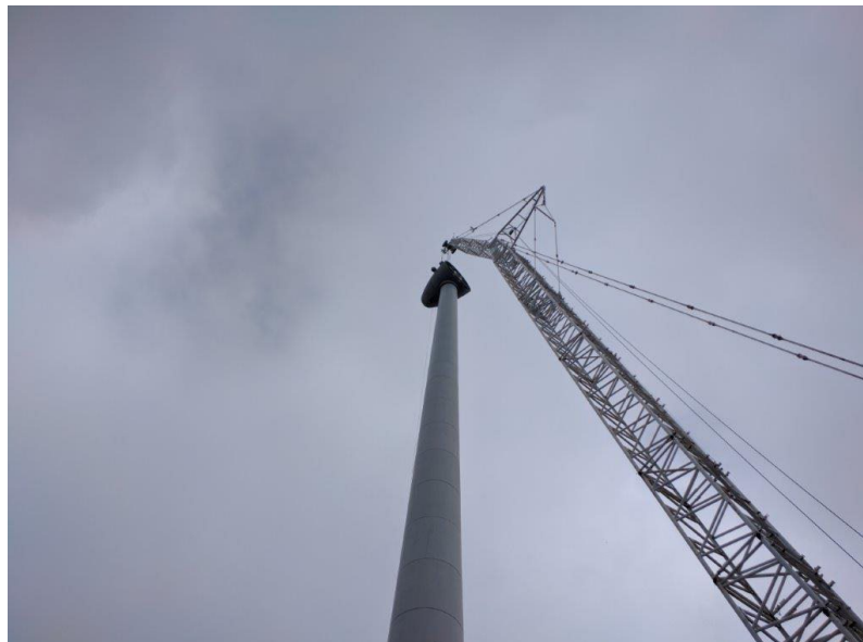
Figura 3.2: Grua para remoção da cabeça do rotor. Autoria da imagem: Finerge .
