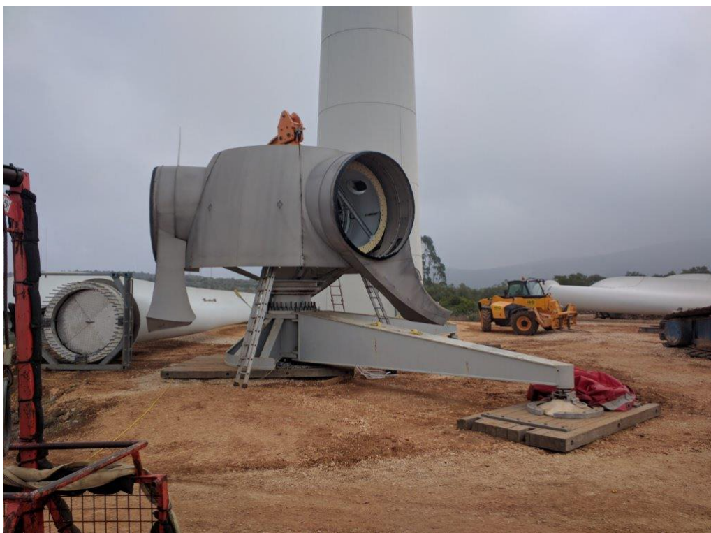
Figura 3.3: Hub do rotor com o veio principal, adaptadores de pá e revestimento da cabeça do rotor. Autoria da imagem: Finerge .
