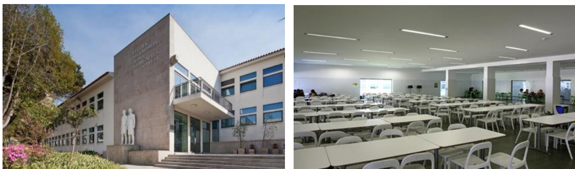
Figura 1 – Entrada principal e espaço interior da Escola Secundária João Gonçalves Zarco (Fonte: Google imagens).
