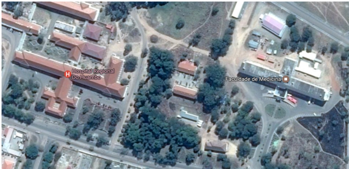
Figura 2. Perímetro do Hospital Regional do Huambo.
