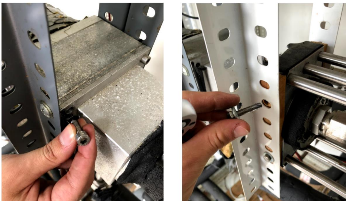
Figura 4.2 - Remoção do ejedor antigo da estrutura de suporte existente na sala das máquinas.
