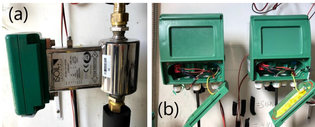
Figura 4.7 – (a) Caudalímetro eletromagnético; (b) conversores dos caudalímetros eletromagnéticos, na fase de instalação das ligações elétricas.
