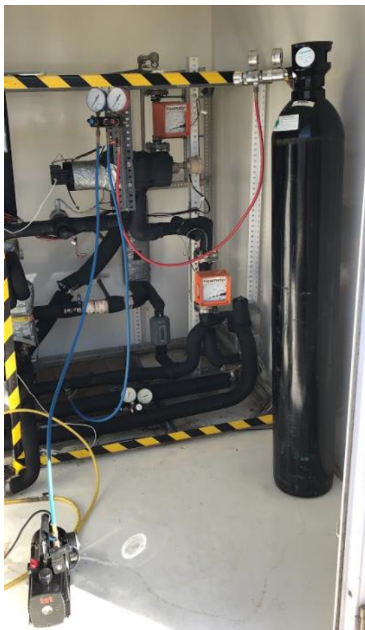
Figura 4.9 - Ligação dos tubos para a inserção de azoto comprimido no circuito de refrigeração.
