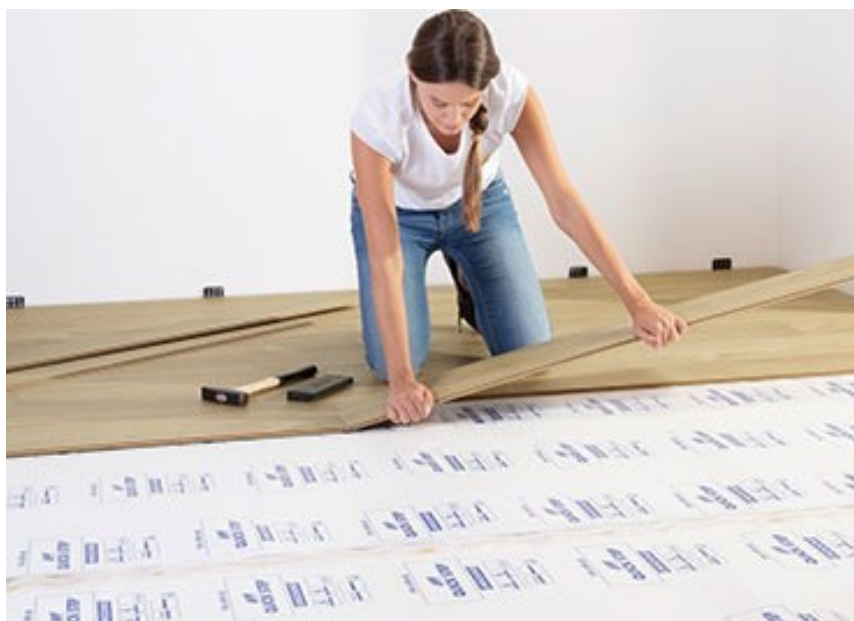
Fig. 3.8 - Processo de instalação de um laminado [56].
