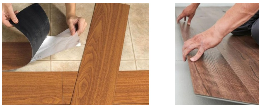
Fig. 3.14 - Diferentes tipos de instalação dos pisos vinílicos [63].
