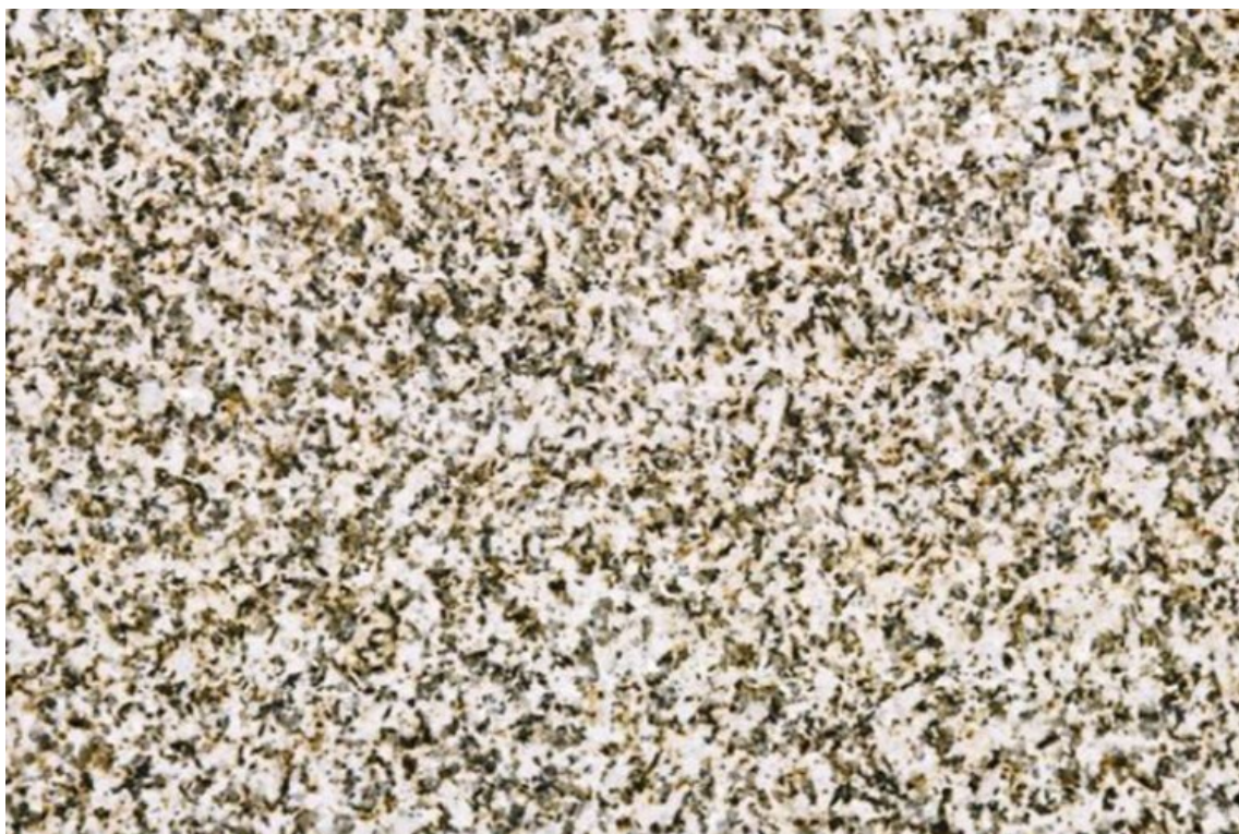
Fig. 3.20 - Exemplo de um revestimento de mármore [74].
