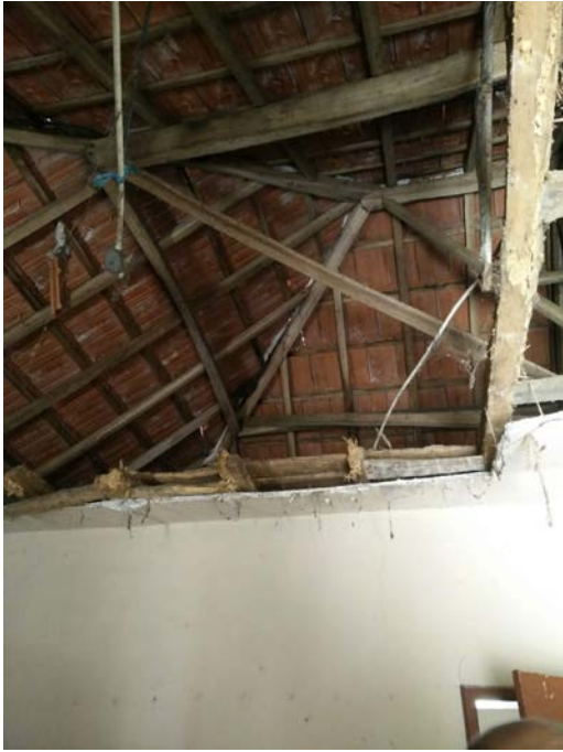
#23 . Fotografia: Estrutura do telhado da casa-mãe.
