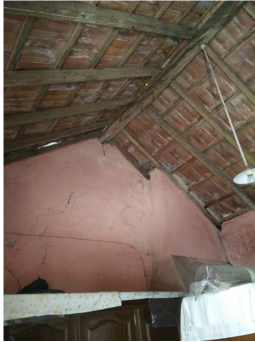
#24 . Fotografia: Estrutura do telhado do espaço [12].
