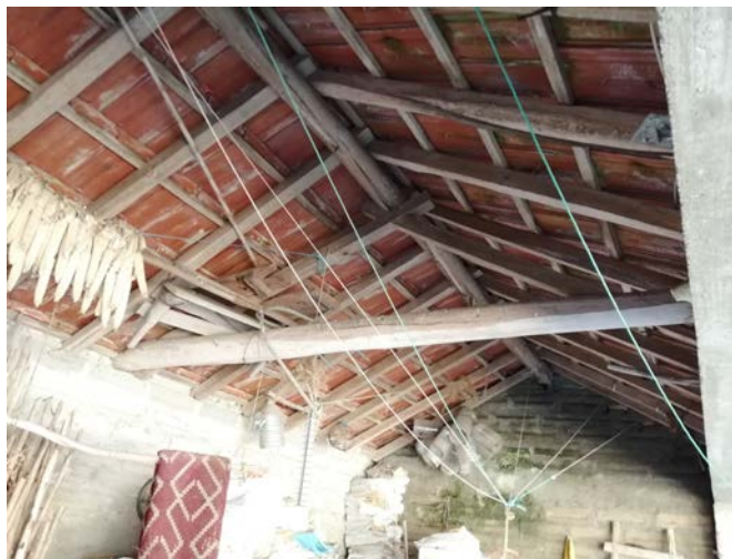
#25 . Fotografia: Estrutura do telhado do cabanal [17].
