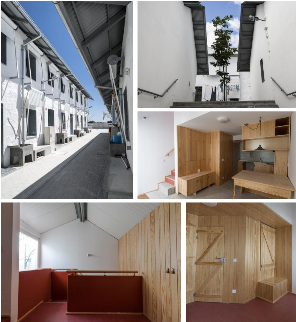
Fig.90/91/92/93- Ilha da Bela Vista, reabilitação, LAHB/CICS.Nova_UMinho/Imago, Gabinete de Arquitetura Cerejeira Fontes, Associação de Moradores da Bela Vista, Porto, 2017.
