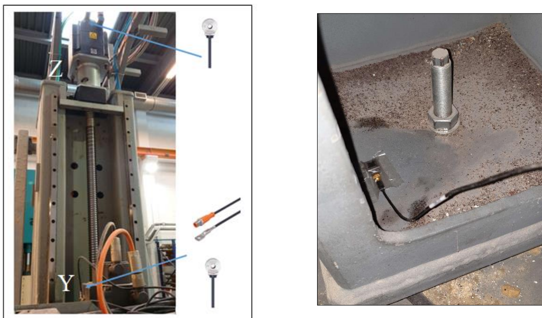
Figura 3.41 - Fixação do sensor de vibração axial VSA005 instalado no corpo do motor Mz na direção do eixo Z, responsável pelo acionamento do veio fuso de esferas do eixo árvore. Fixação do sensor de temperatura TS2229 e sensor de vibração VSA005 implementados na direção do Eixo Y, no corpo do motor My (esquerda); Fixação do Sensor de vibração triaxial 4535-B na estrutura rígida da máquina (direita).
