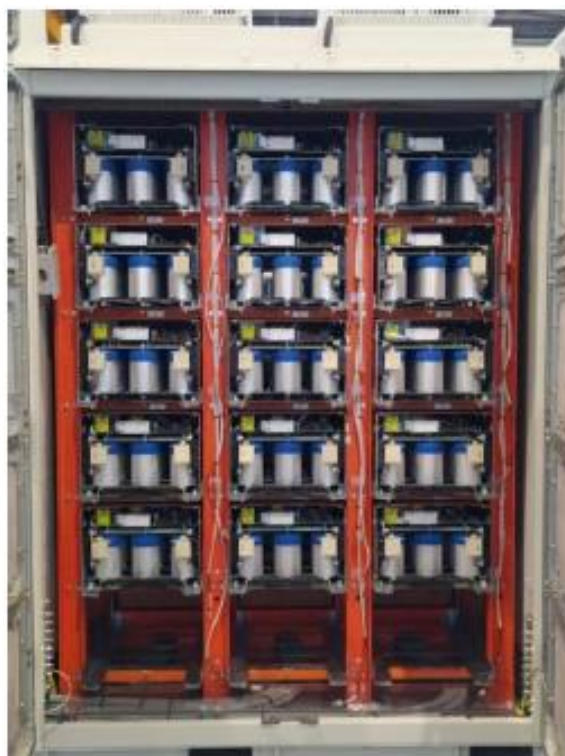
Figura 5.4: Armário das células de potência do MVW3000.
