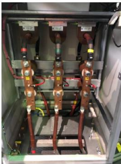
Figura 4.6: Ligações dos TT e TI.
