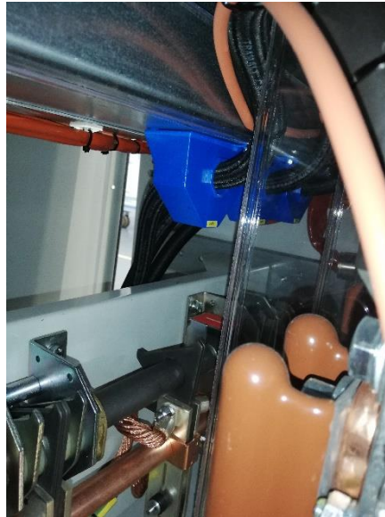
Figura 4.7: Ligações do HCT para medição das grandezas à saída do inversor.
