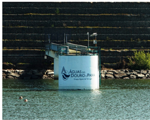
Figura 4 - Captação Lever Jusante
