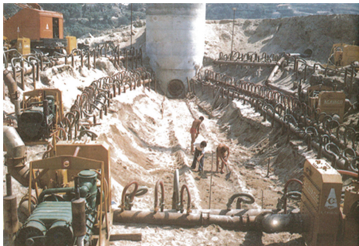
Figura 1 - Construção dos poços subaluvionares.
