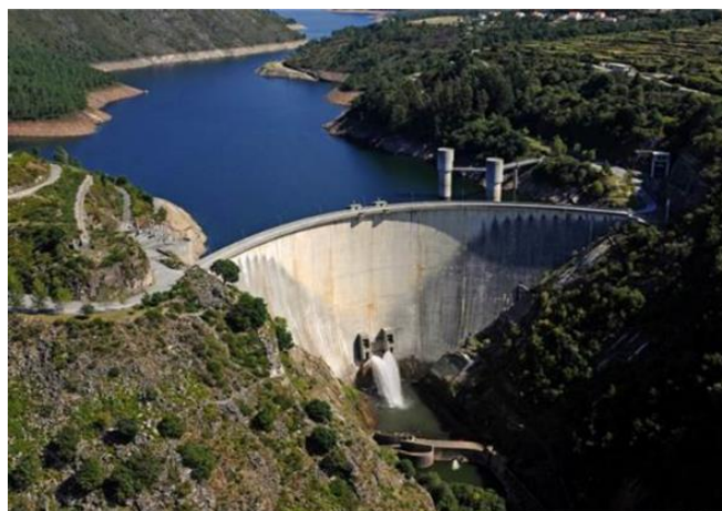
Figura 2.2- Vista geral da barragem do Alto Lindoso.
