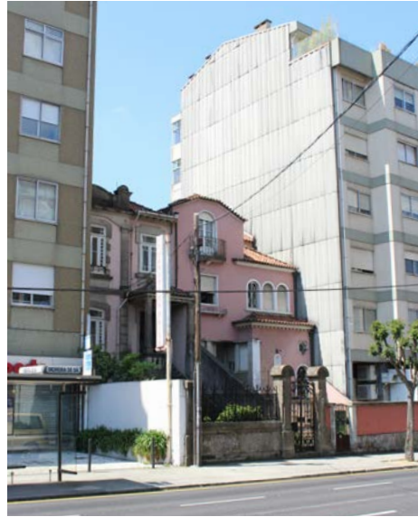
Figura 17 / Tomás F. Ceitlin Casa Burguesa na Rua de 5 de Outubro em estado de conservação razoável, 2019
