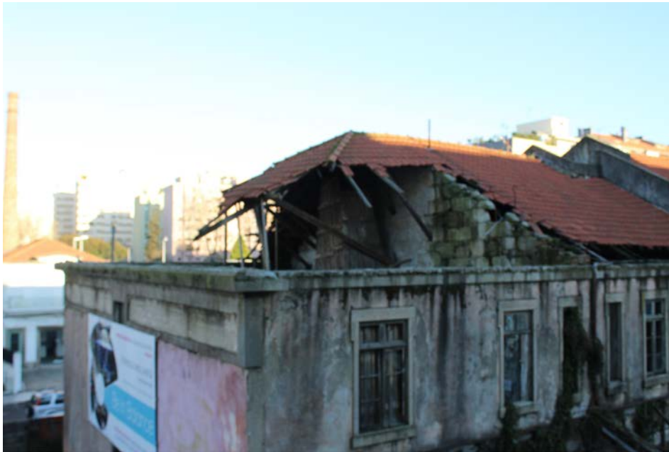
Figura 33 / Tomás F. Ceitlin Pormenor da cobertura, evidenciando a separação entre as habitações e estrutura da cobertura, 2019
