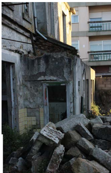
Figura 47 / Tomás F. Ceitlin Edícula que corresponde ao quarto de banho exterior, 2019
