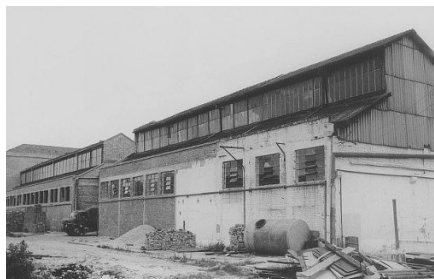
Figura 81 / Acervo Estadão Pavilhões do SESC Pompéia durante as obras, 2013.
