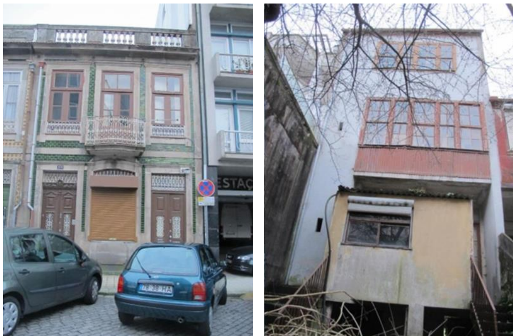
Figura 3.10 - Fachada frontal e de tardo do Edifício C (Rocha, 2019)
