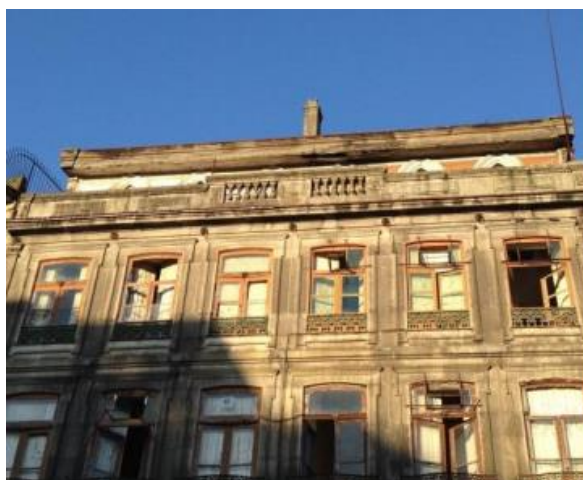
Figura 2.3 – Platibanda e chaminé na Rua Mouzinho da Silveira (Lopes, 2019)
