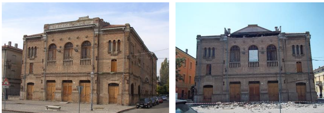
Figura 1.4 – Queda de platibanda na região de Reggio Emilia (www.wikipedia.com, 2020)
