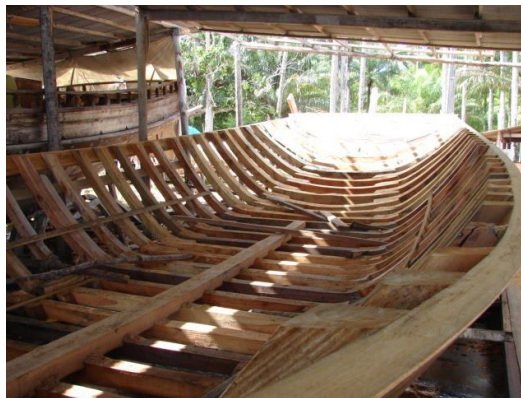
Figura 21 Quilha e cavernas de uma embarcação a ser construída [9]
