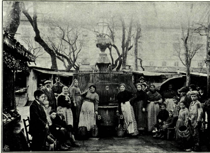
Fig. 56 — Chafariz do Mercado do Anjo mostrando as bicas B B destinadas á lavagem das hortaliças e a grade G de protecção da agua do tanque, d'onde, no lado opposto a B B , emerge uma bica de piston e jacto ascendente para servir á bebida
