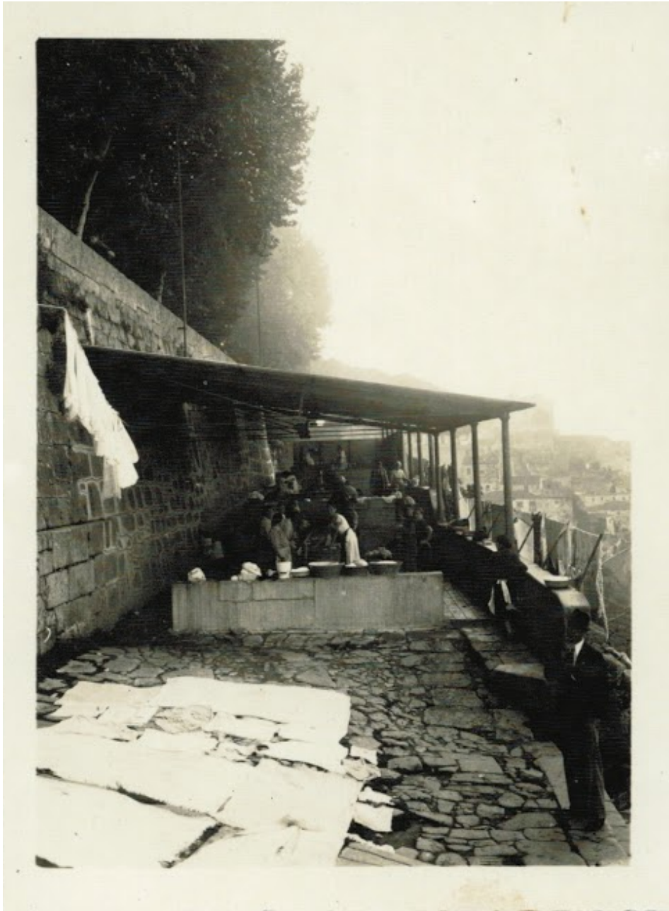
38. Type Moderne 1 , Lavadouro das Fontainhas, U2IP - Águas do Porto, 1940
