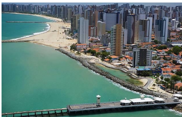
Figura 1.6. Vista da orla marítima de Fortaleza-CE [19]
