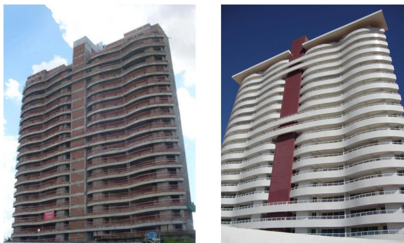
Figura 9.3. Fotos do Edifício 03
