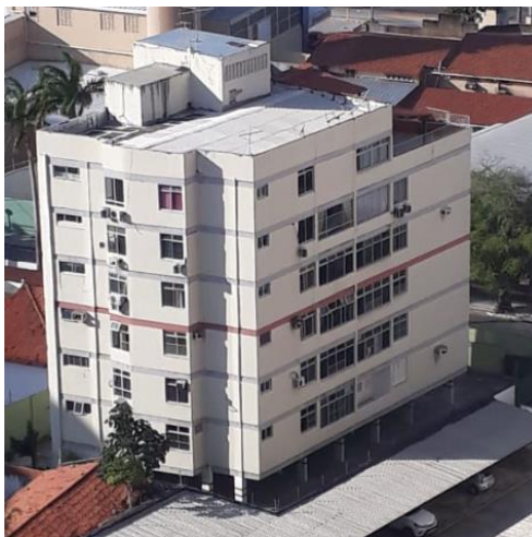
Figura 16.2. Edifício residencial sem fechamento de alvenarias no térreo
