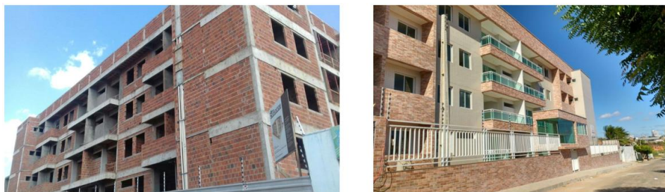
Figura 9.1. Fotos do Edifício 01
