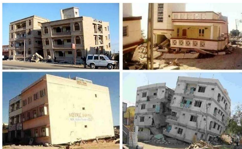
Figura 16.1. Colapsos de edificações pelo mecanismo de soft-storey [129]
