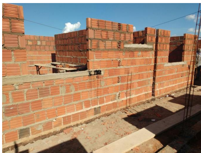
Figura 1.4. Sistema construtivo de residência em alvenaria
