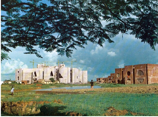
[95] Edifício da Assembleia Nacional do Bangladesh em construção, Daca, 1975.
