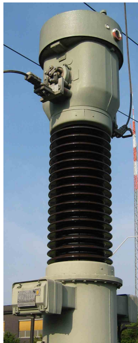
Figura 2.5: Transformador de Corrente [5]
