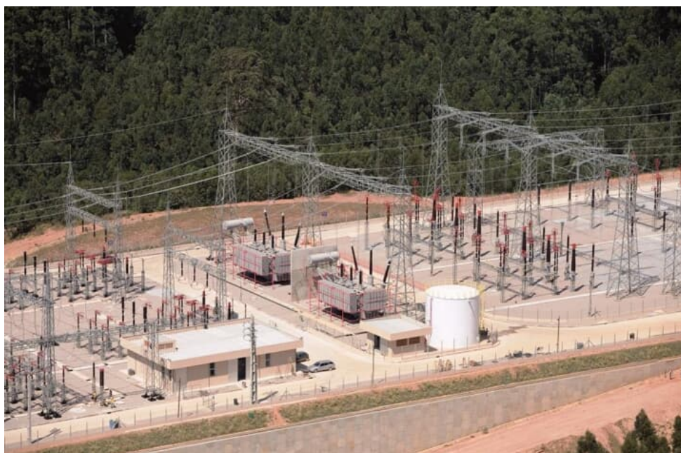
Figura 2.3: Subestação AIS [3]
