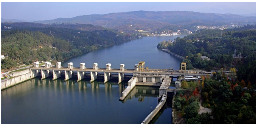
Fig. 41 - Overhead view of Crestuma dam (© IPTM, F. Piqueiro /Foto Engenho).
