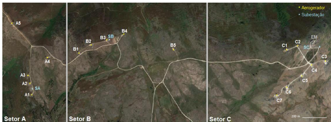
Figura 6.3 - Setor A, B e C do parque eólico.
