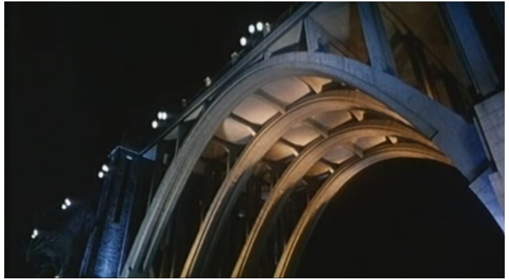
Fig. 82 - Viaduto de Segóvia, calle Bailén .
