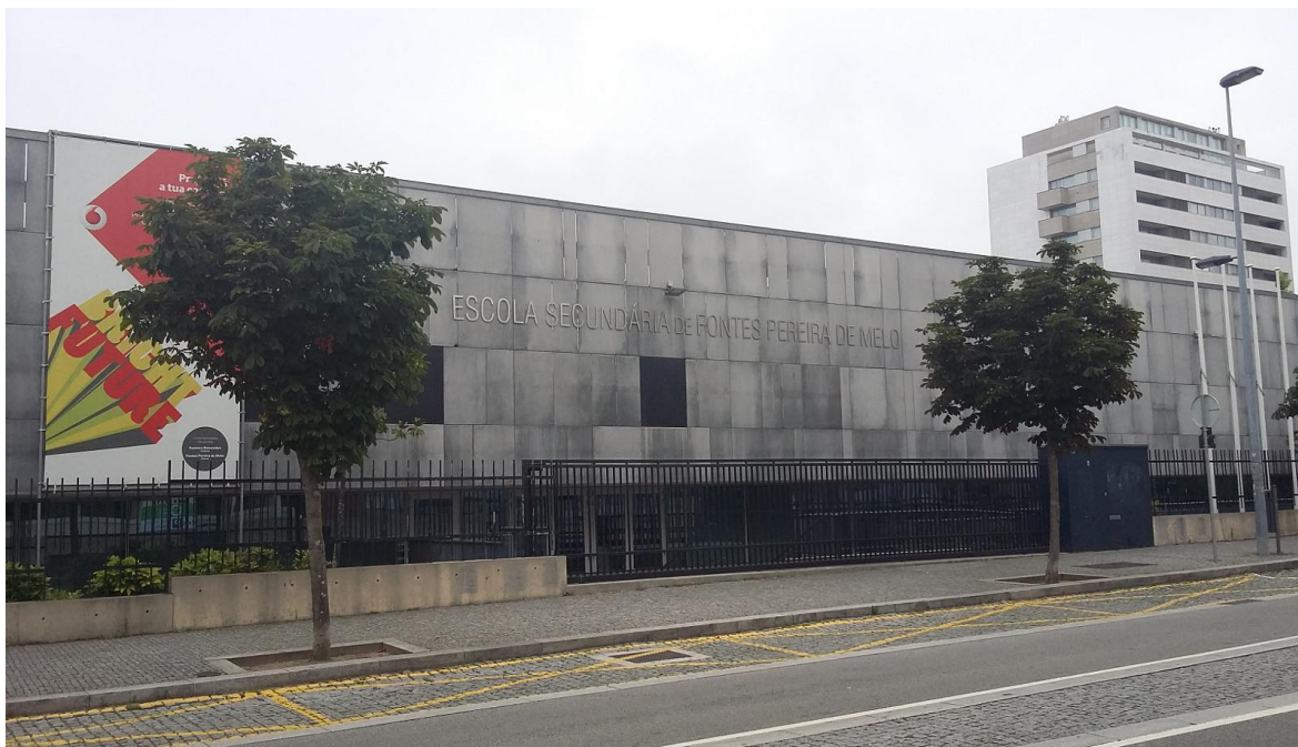
Figura 4 - Fachada da Escola Secundária Fontes Pereira de Melo
