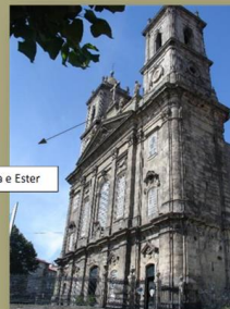
Figura 15- Vista lateral da fachada
