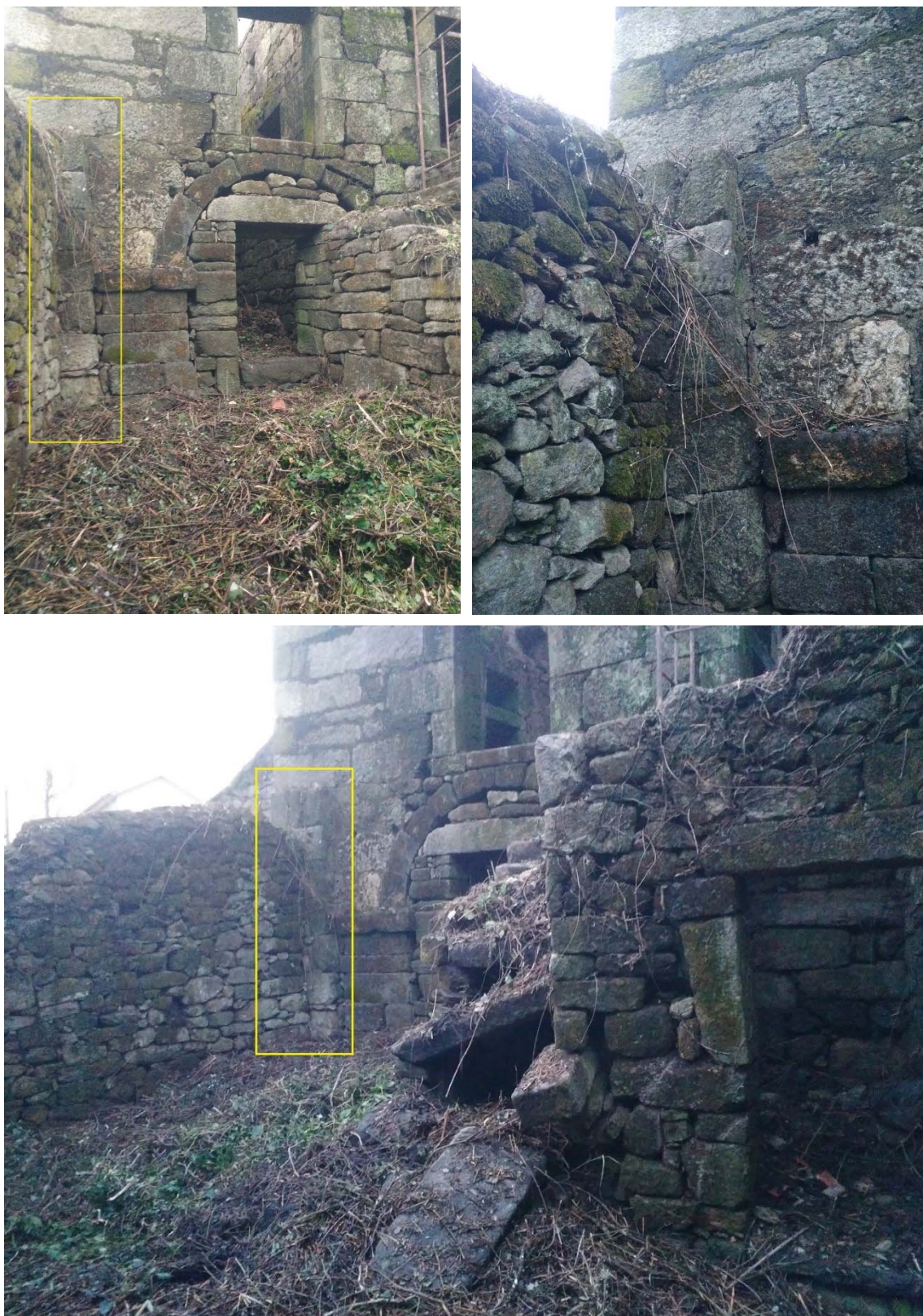
Figura 8 – Resto de parede primitiva do corpo C
