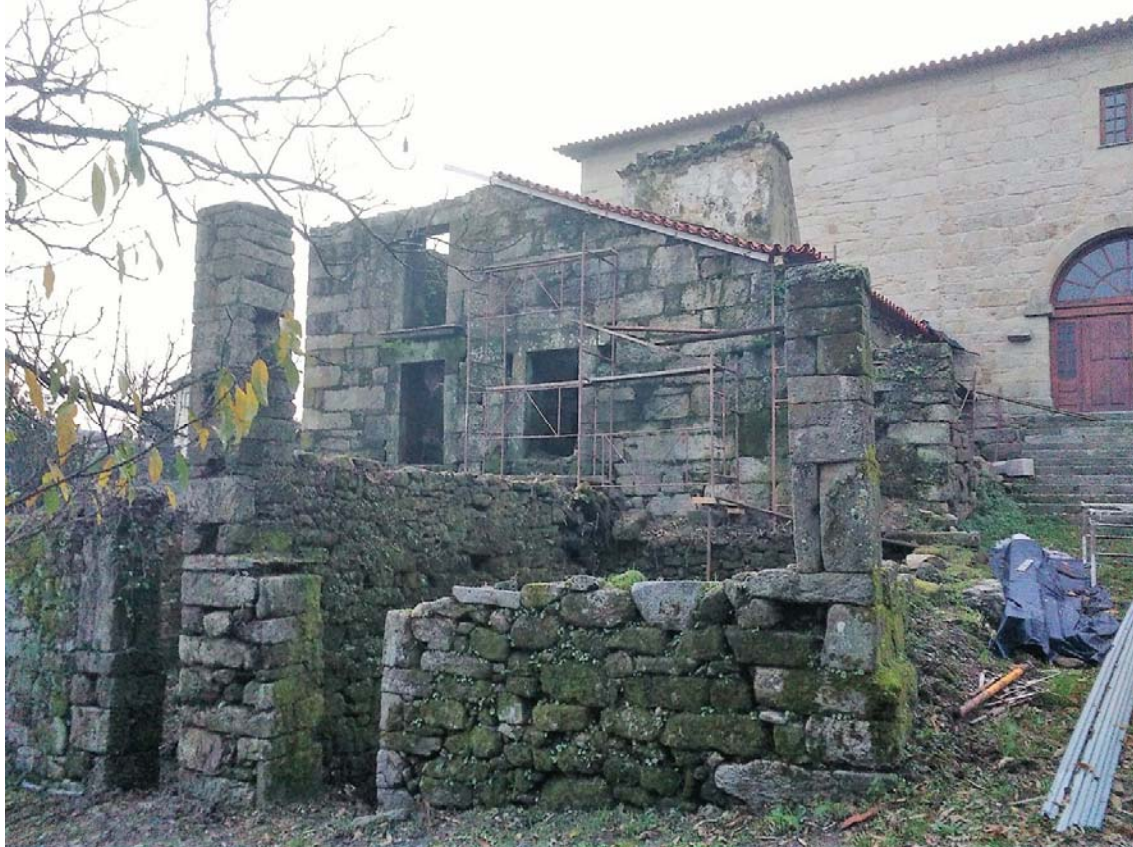
Figura 7 – Pilares que suportariam telhado; ao fundo, corpo S e parte do N; em plano intermédio, corpo C)
