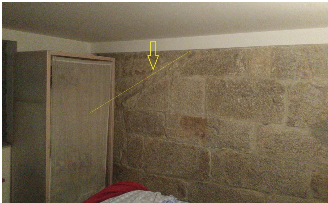
Figura 6 – Parede poente do corpo O, onde assentou a parede nascente do corpo N
