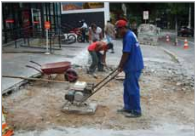
1 Adequação do terreno
