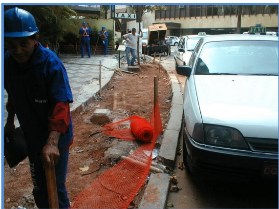
antes – preservação do meio fio histórico
