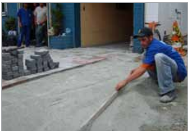
3 Espalhamento e nivelamento de areia de assentamento
