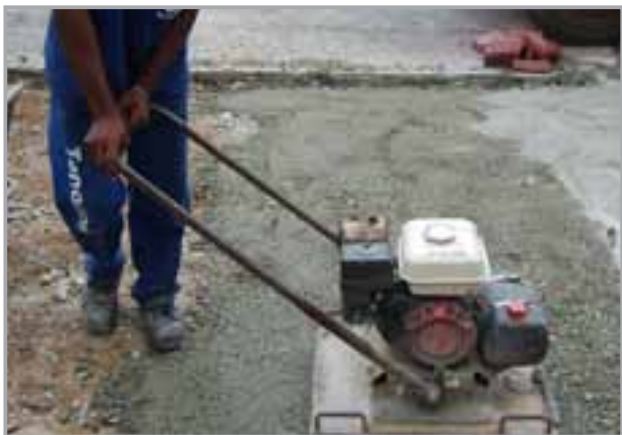
2 Montagem da base e contenções laterais
