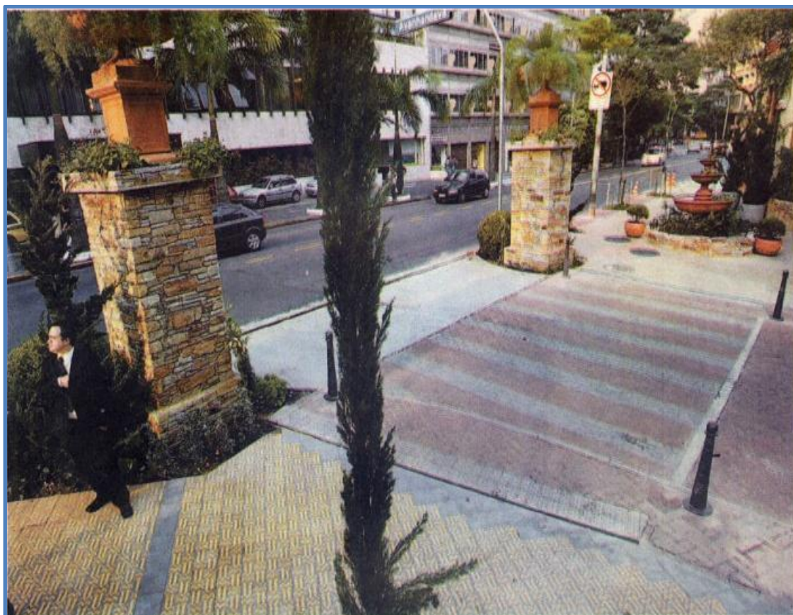
Pórtico na rua Avanhadava, na região da Bela Vista, que passa por revitalização; calçadas foram alargadas e fios, enterrados
