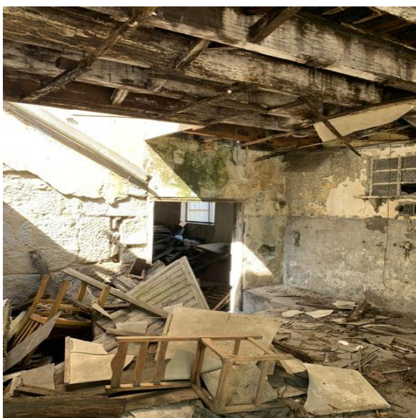
Fig. 3.4 – Interior do Edifício antes da limpeza
