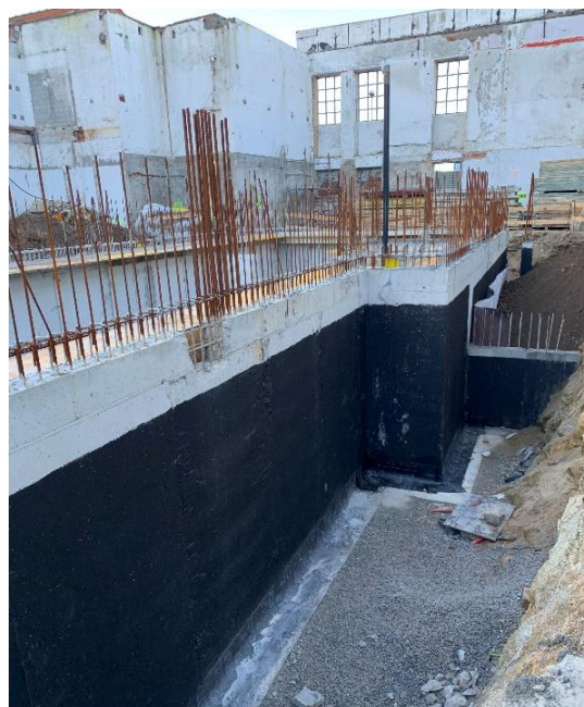
Fig. 3.28 – Colocação Impermeabilizante Muros
