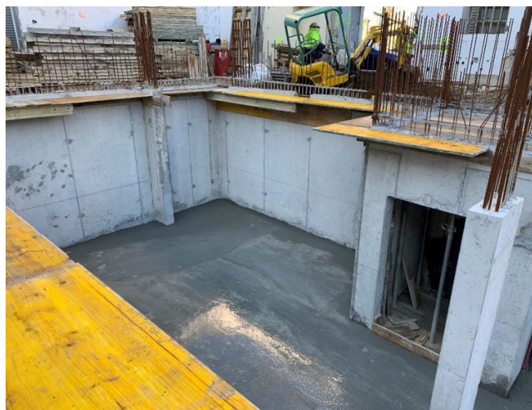
Fig.3.29 – Acabamento na Laje de Ensoleiramento
