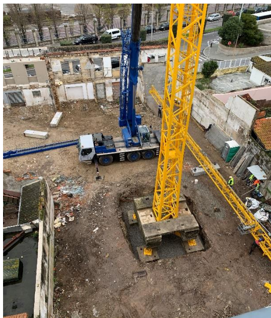
Fig.3.12 – Montagem da Grua
