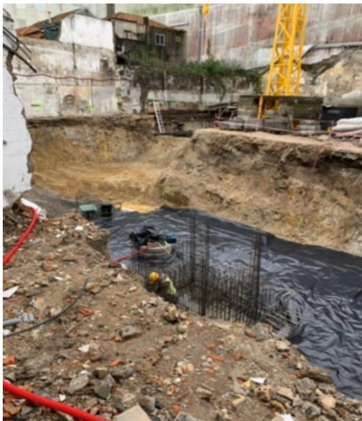
Fig. 3.23 – Colocação Tela Impermeabilizante
