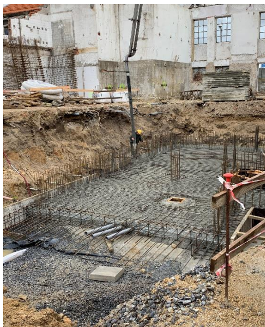
Fig.3.26 – Betonagem do Ensoleiramento geral
