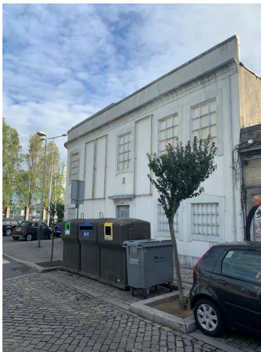
Fig.2.2. – Fachada Principal Edifício em outubro 2020 (poente)
