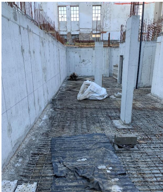
Fig. 3.27 – Após execução de betonagem
