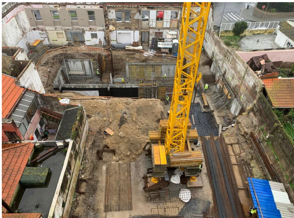
Fig. 3.34 – Vista Superior da Obra (dezembro 2020)
