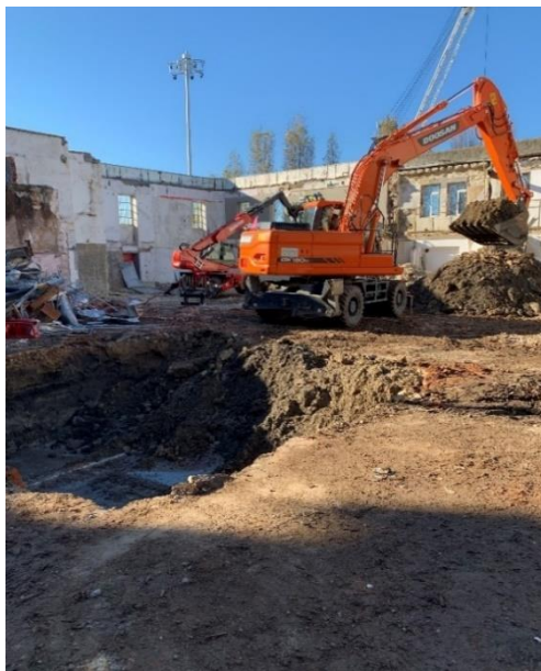
Fig.3.11 – Escavação para sapata da grua
