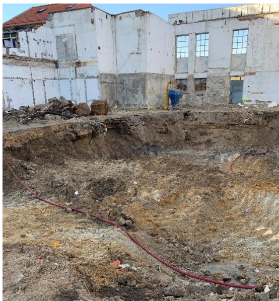
Fig. 3.15 – Escavação Terreno (frente)
