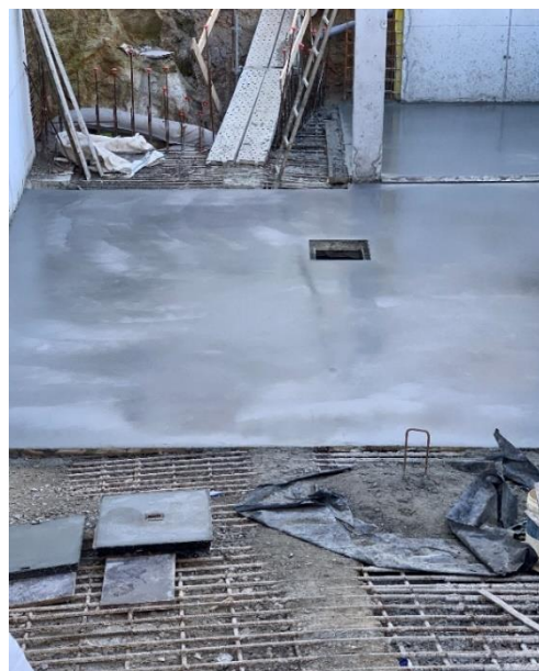
Fig. 3.33 – Acabamento Rampa
