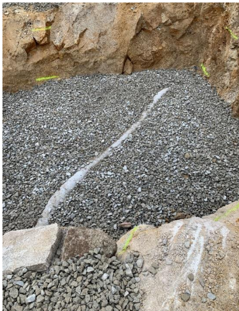
Fig. 3.20 – Rede de Drenagem Enterrada
