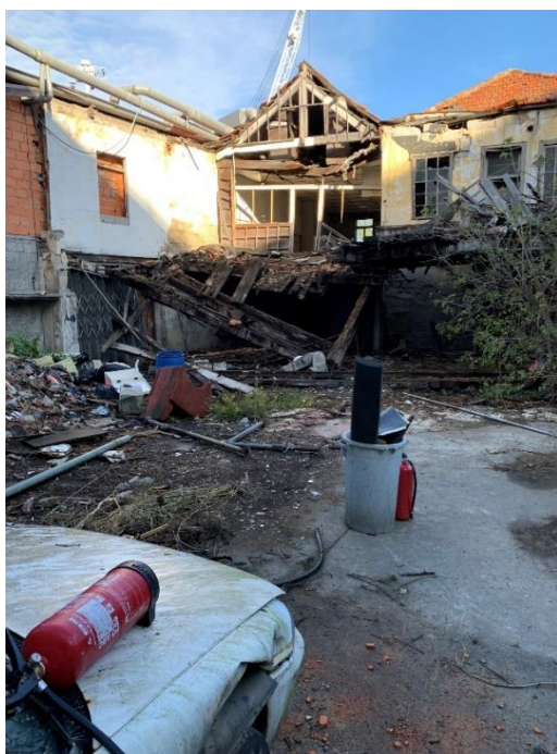
Fig. 3.5 – Exterior do Edifício antes da limpeza (1)
