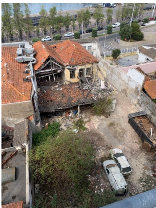
Fig. 3.7 – Exterior do Edifício antes da limpeza (3)
