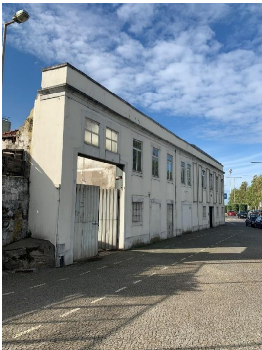
Fig.2.1. – Fachada Principal Edifício em outubro 2020 (nascente)
