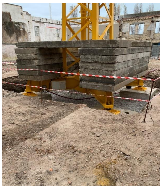
Fig.3.13 – Sapata da Grua
