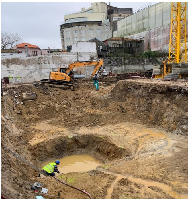
Fig. 3.19 – Escavação do Terreno em curso – outubro 2020
