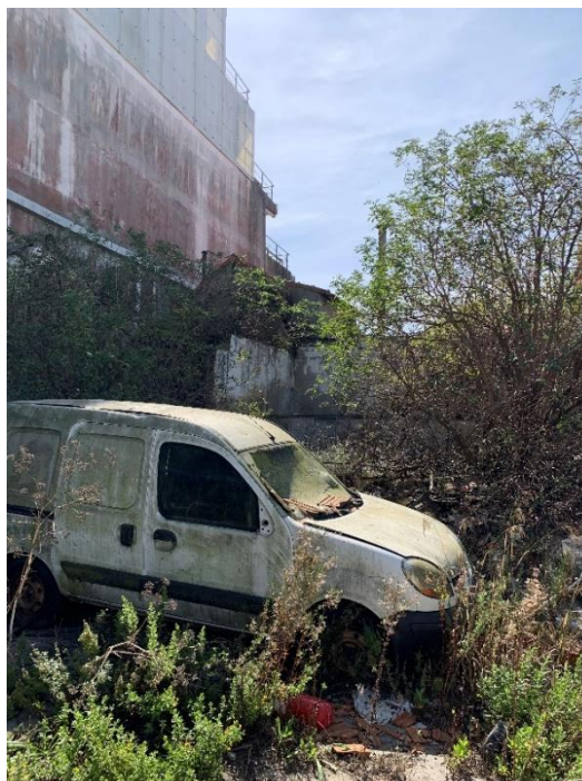
Fig. 3.8 – Exterior do Edifício antes da limpeza (4)
