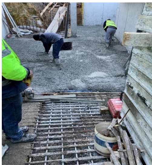
Fig. 3.31 – Rampa Exterior (betonagem)
