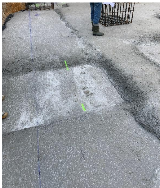
Fig. 3.24 – Colocação Betão Limpeza
