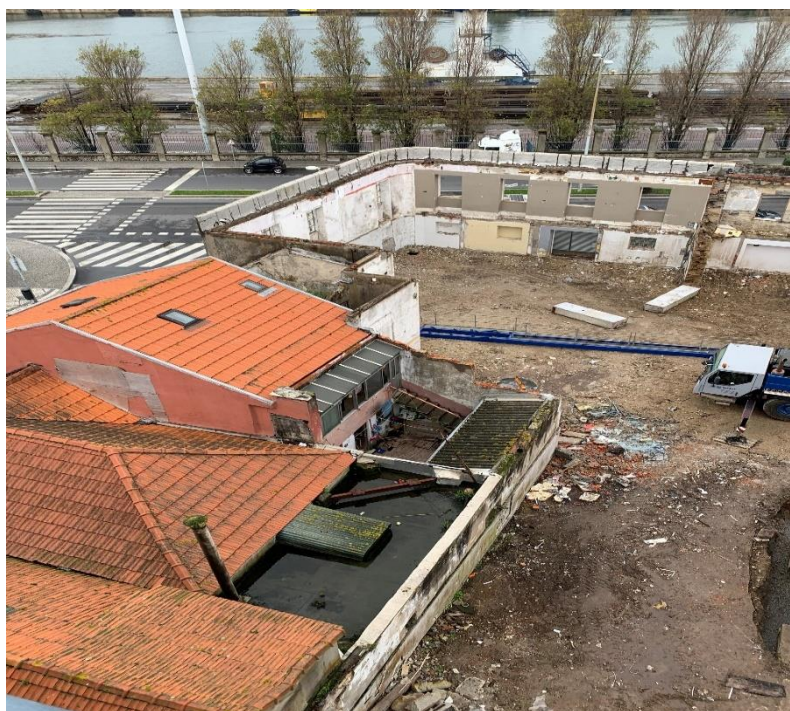
Fig.3.10 – Vista aérea do local da obra após demolições
