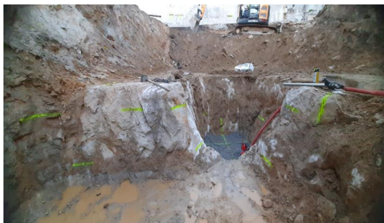
Fig.3.14 – Escavação geral do terreno e localizada do poço de elevador
