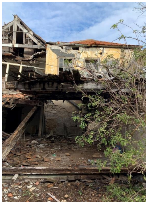
Fig. 3.6 – Exterior do Edifício antes da limpeza (2)
