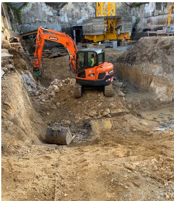
Fig. 3.17 – Escavação Terreno (rampa e logradouro)
