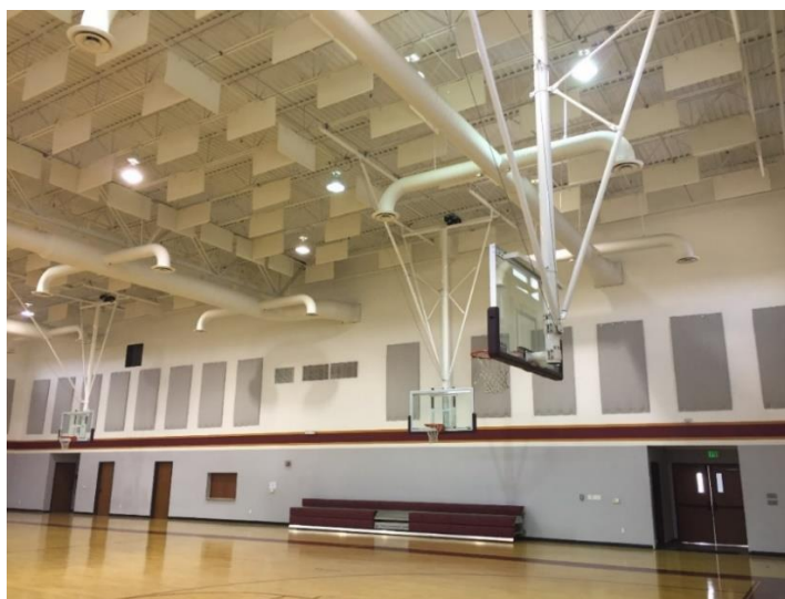
Figura 7.1 – Exemplo de aplicação de baffles em ginásio. [96]
