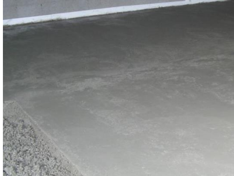
Figura 31 – Pavimento em betão leve [18]
