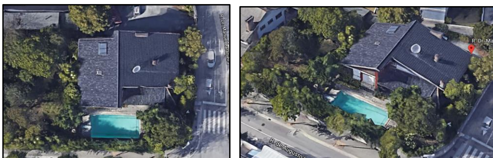
Figura E.3 Fotografia retirada do Google Maps da habitação unifamiliar localizada na Rua Do Dr. Manuel Laranjeira, – Paranhos
