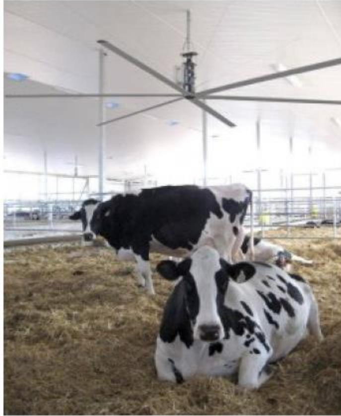
Figura 7 – Ventoinha de grande volume e baixa velocidade (Fonte: Minnesota clean energy resource teams presentation)
