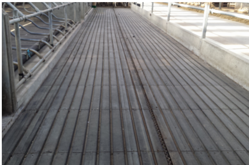
Figura 1. Pavimento contínuo com sulcos para boa aderência dos animais e de baixa emissão de amoníaco.
