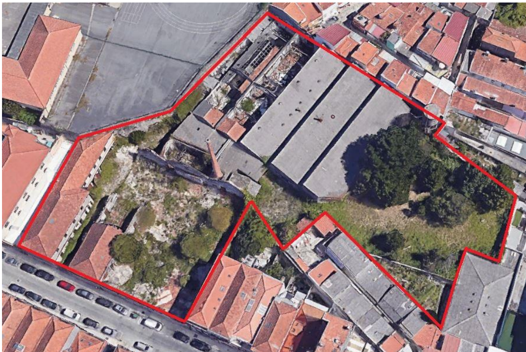
Fig. 3.1. – Fotografia aérea da área de intervenção, Fonte Google Earth.
