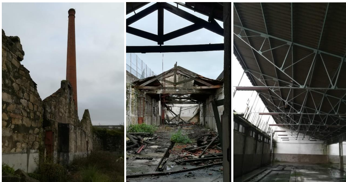
Fig. 3.2. – Fotografias do local antes da intervenção, Fonte Google Fotos (Drive do Diretor de Obra).
