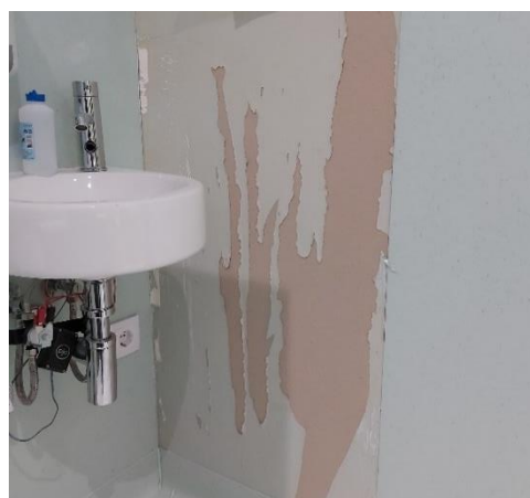
Figura 121 - Fotografia da correção da anomalia na parede.
