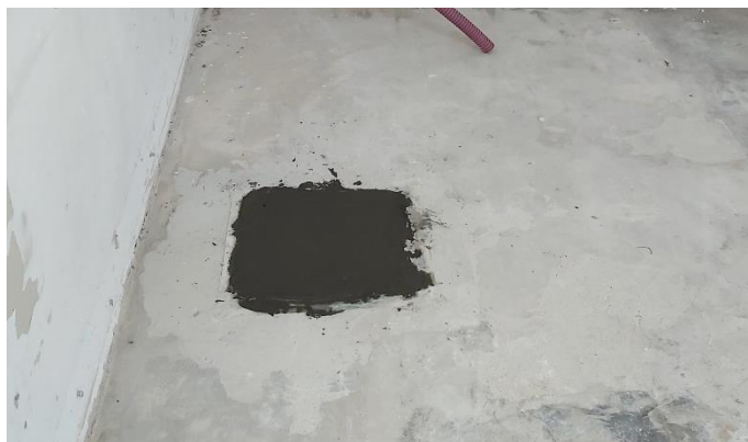
Figura 64 - Fotografia da medida corretiva: aplicação de um cimento adequado.
