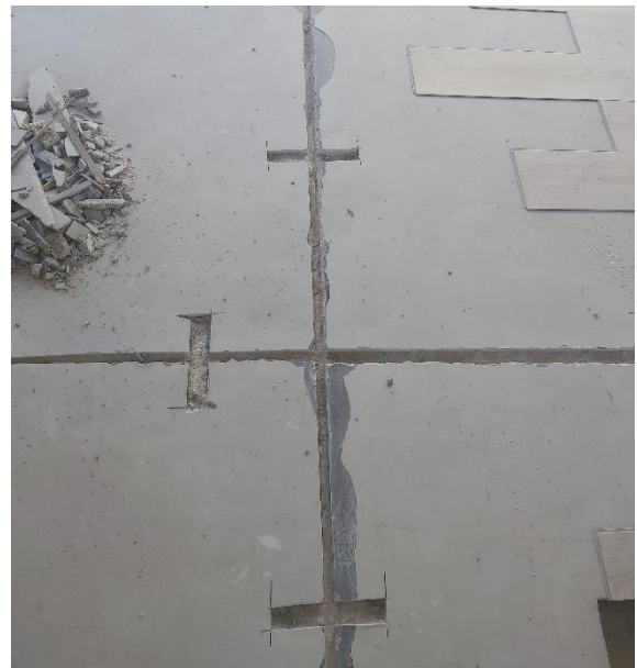
Figura 49 - Fotografia da selagem das juntas de retração em pormenor.
