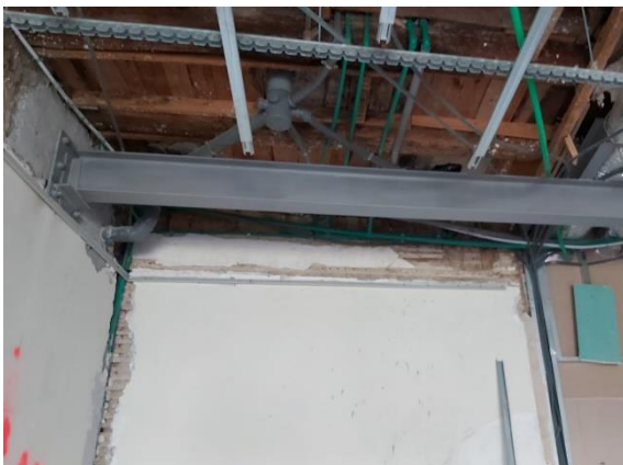
Figura 73 - Fotografia do reforço estrutural realizado.
