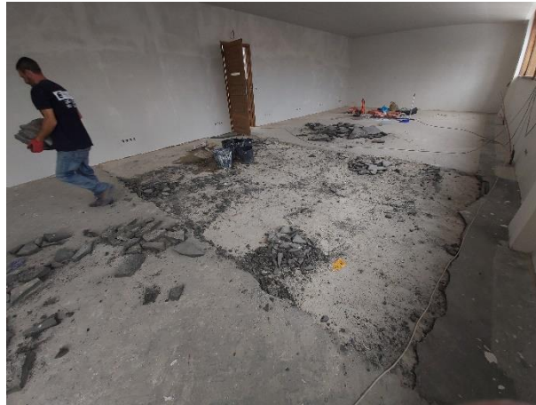
Figura 109 - Fotografia da correção do pavimento.
