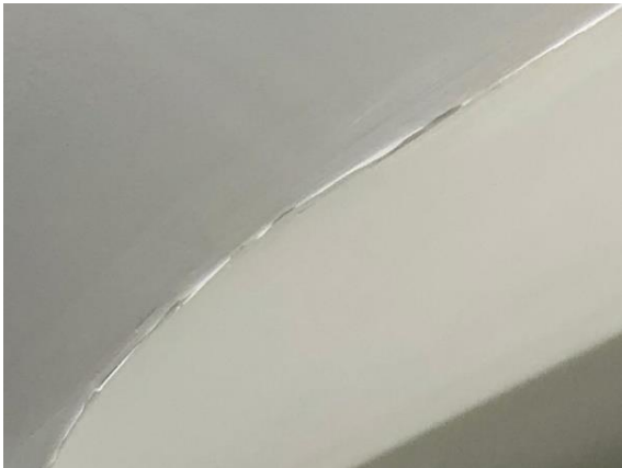
Figura 114 - Fotografia da aresta entre teto e parede.
