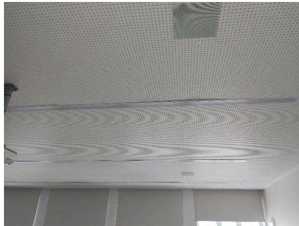
Figura 105 - Fotografia do teto falso aplicado na obra em questão.
