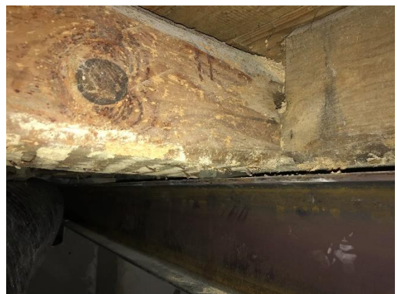
Figura 74 - Fotografia do reforço estrutural realizado em pormenor.
