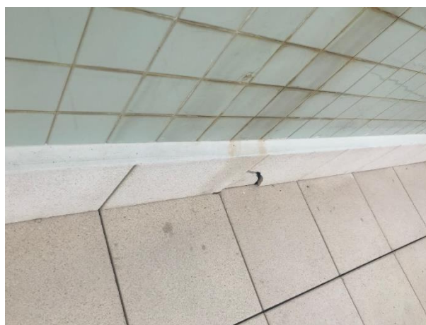
Figura 81 - Fotografia elucidativa do rodapé partido.
