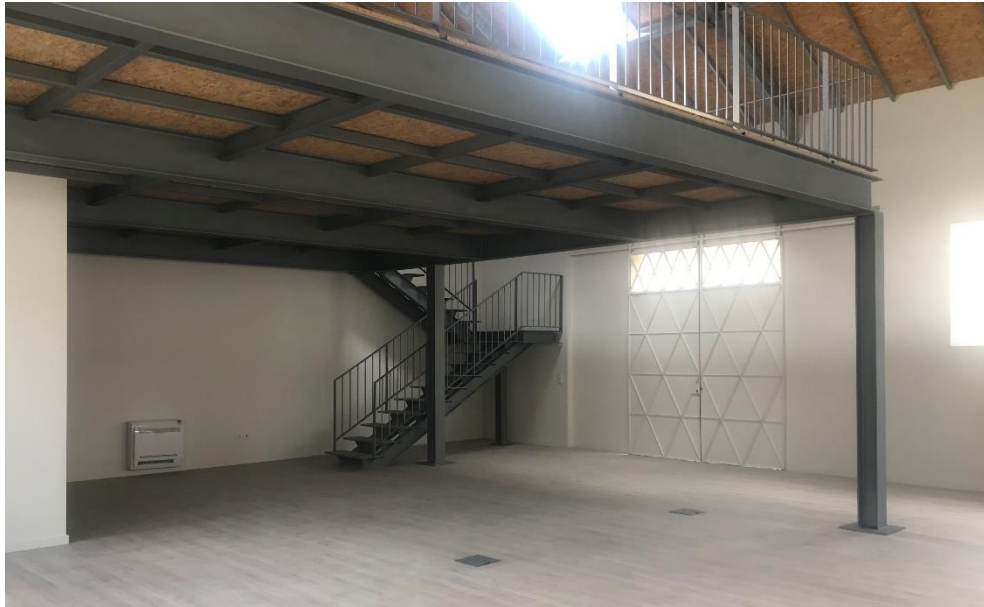
Figura 53 – Fotografia da estrutura metálica que suporta o mezanino.
