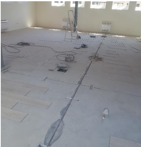
Figura 48 - Fotografia da selagem das juntas de retração.
