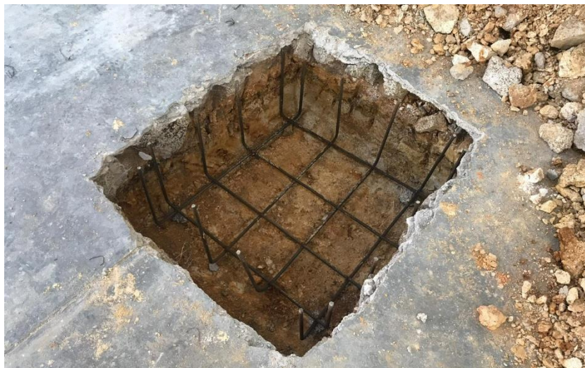
Figura 52 - Fotografia da execução das sapatas.
