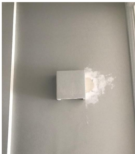
Figura 84 - Fotografia da mudança de posição do applique na parede.
