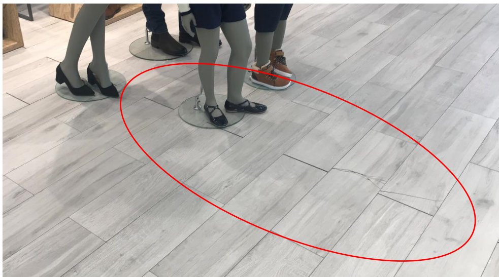
Figura 87 - Fotografia do levantamento do pavimento.
