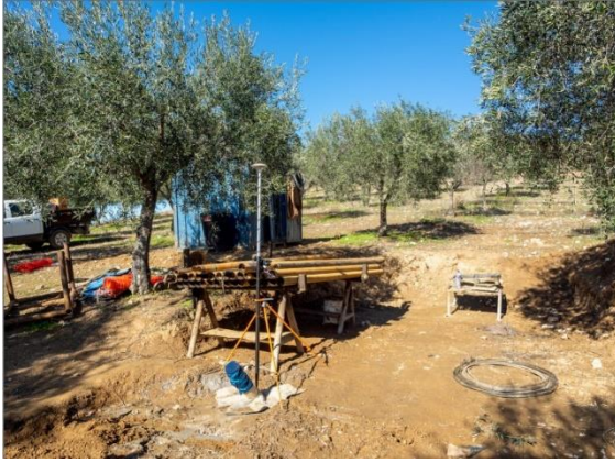
Fig. 24 – Obtenção, após o fim da sondagem, da coordenada exata da boca de furo de sondagem, através de um topógrafo com recurso a um GPS diferencial.
