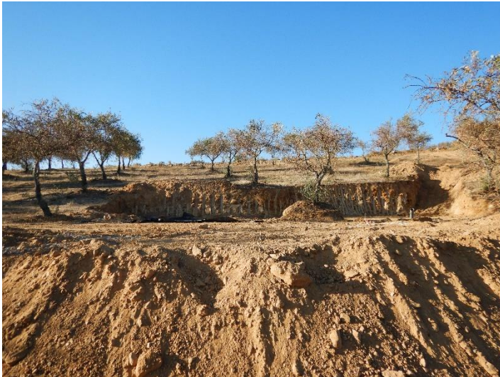
Fig. 20 – Acompanhamento da fase de abertura de caminhos temporários de acesso, bem como das respetivas plataformas, onde posteriormente se procedeu à realização das sondagens carotadas.
