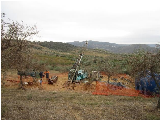
Fig. 22 – Correta colocação da sonda na plataforma de sondagem.
