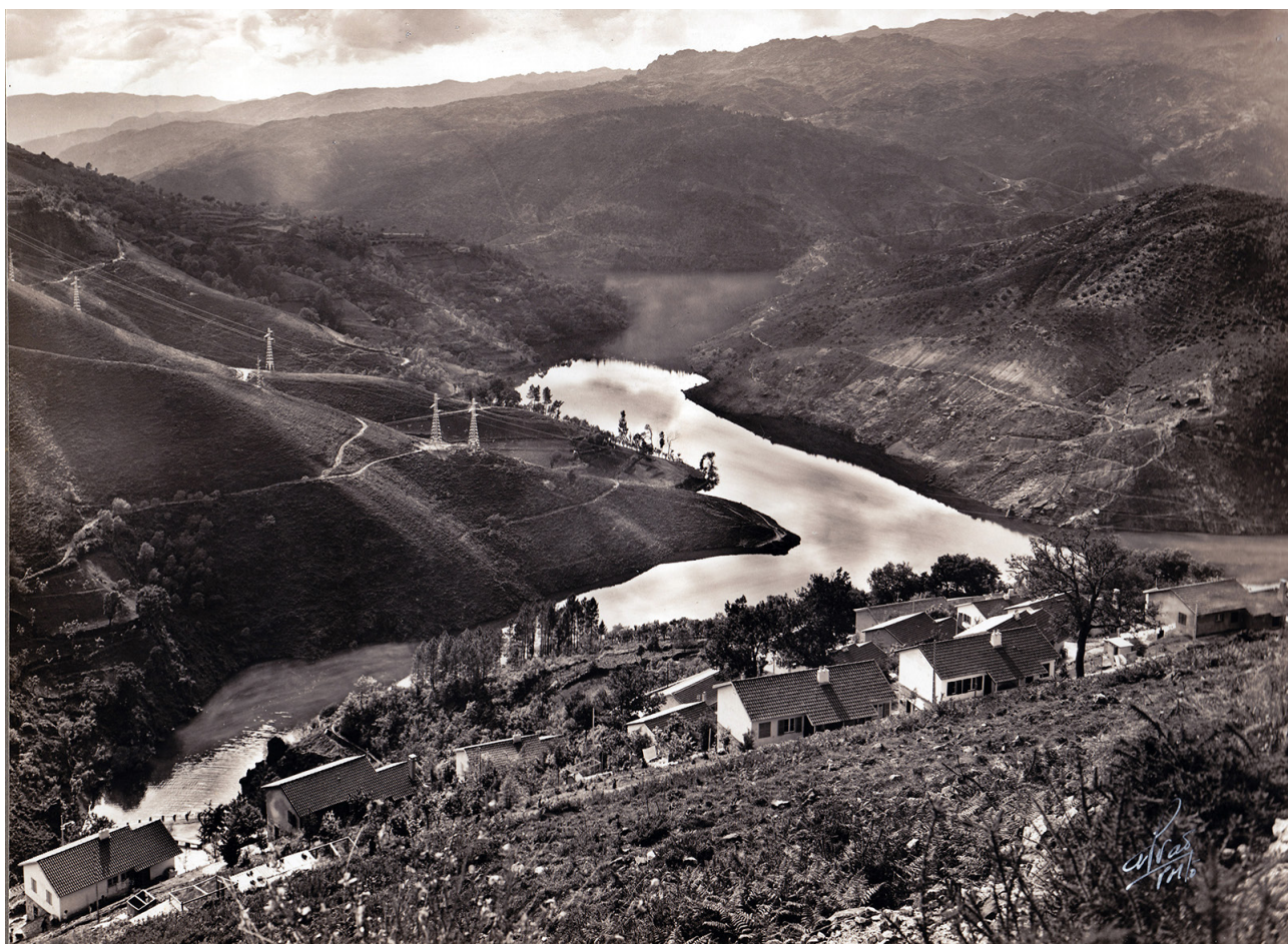
Fig. 155. Bairro dos operários da barragem de Venda Nova, Junho de 1956.
