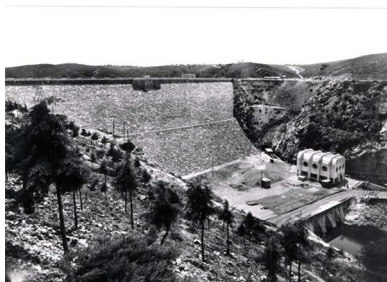
Fig. 119. Barragem Salazar, JAOHA, arquitecto Cassiano Branco, 1937.
