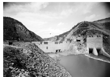
Fig. 127. Construção da barragem de Castelo de Bode, s/d.
