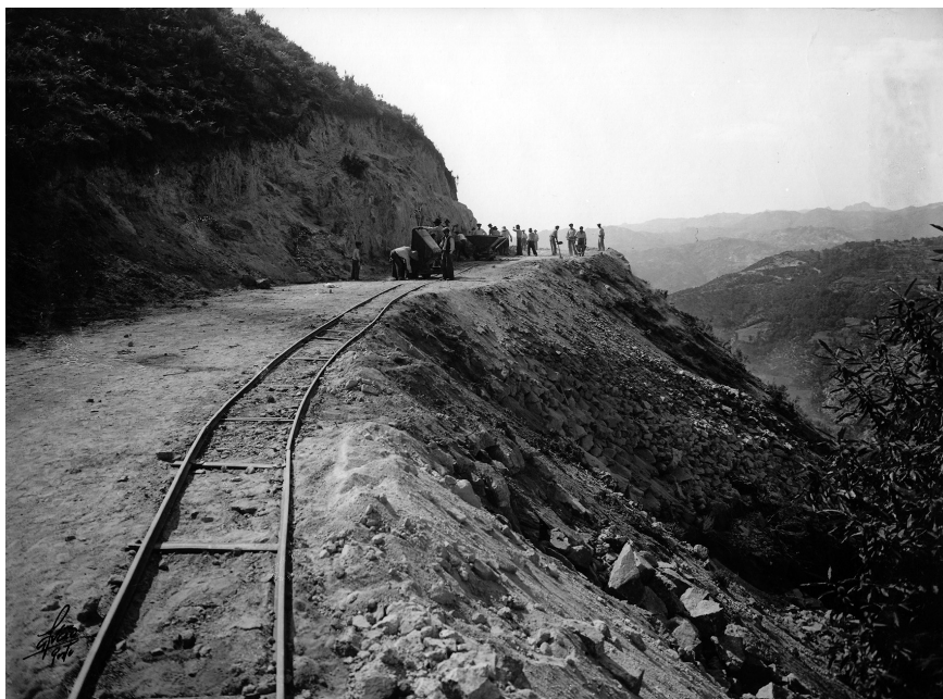
Fig. 228. Abertura da estrada de acesso ao local da futura barragem de Venda Nova, Setembro de 1947.
