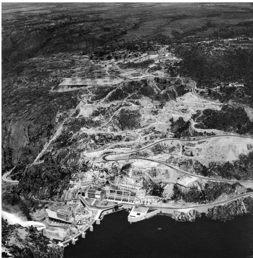
Fig. 123. Estaleiro e bairro da central da barragem de Picote, Douro Internacional, 1956.
