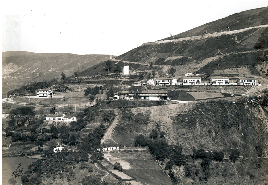
Fig. 42. Primeira fase do bairro dos operários da central de Vila Nova concluída, Maio de 1950.
