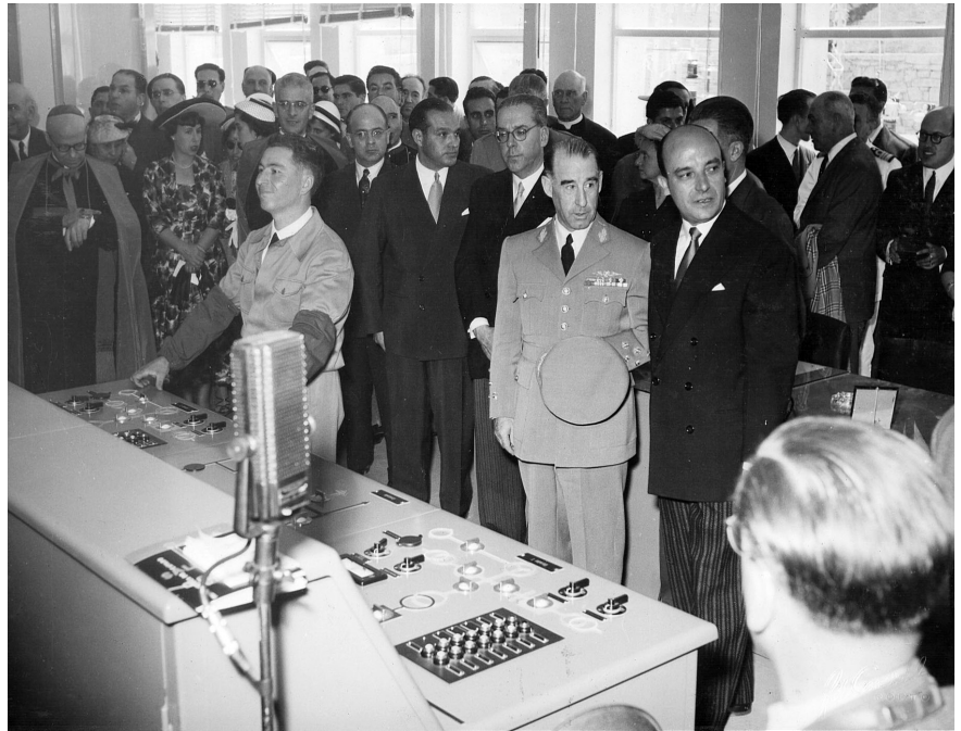
Fig. 238. Sala de comando da central de Salamonde, 1953.
