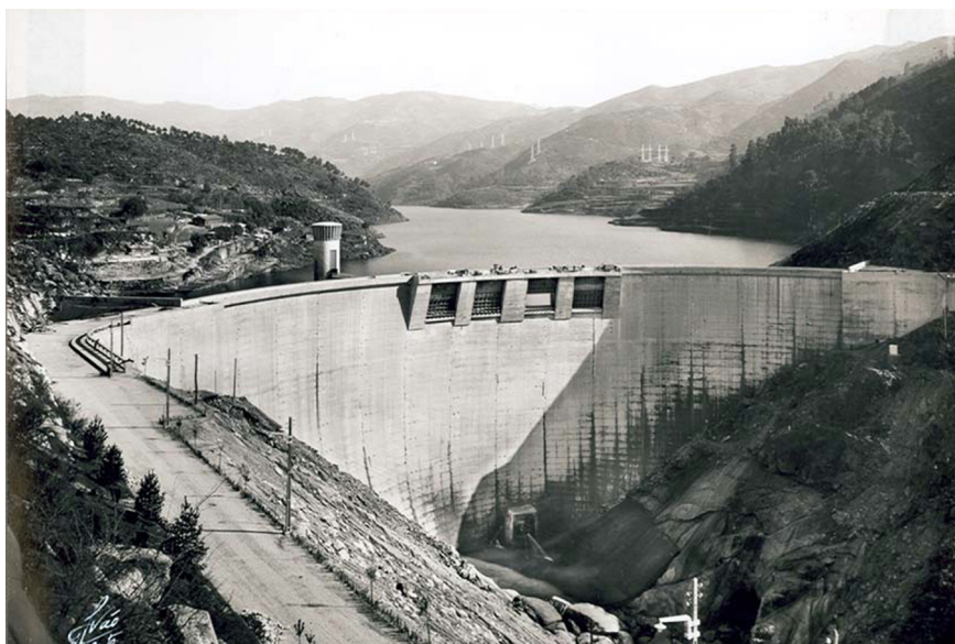
Fig. 74. Barragem de Caniçada, 1955.
