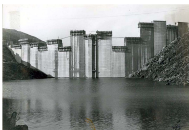
Fig. 16. Construção da Barragem de Venda Nova, Dezembro de 1950.
