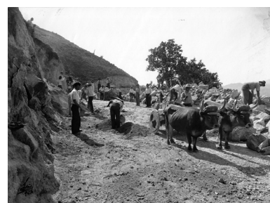
Fig. 226. Abertura da estrada de acesso ao local da futura barragem de Venda Nova, Agosto de 1947.
