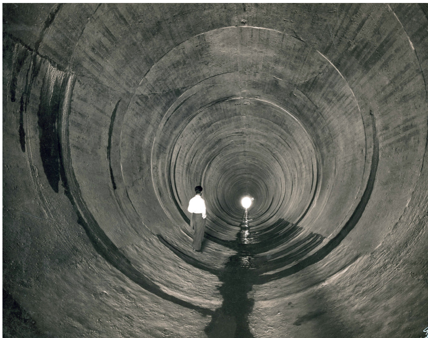
Fig. 75. Túnel de restituição ao rio das águas turbinadas na central de Caniçada, Dezembro de 1953.
