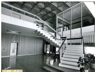
Fig. 105. Hall de entrada do edifício de comando da barragem do Alto Rabagão, Maio de 1965.
