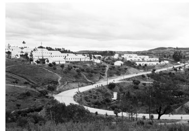
Fig. 125. Dormitórios dos estaleiros da obra da barragem de Castelo de Bode, s/d.
