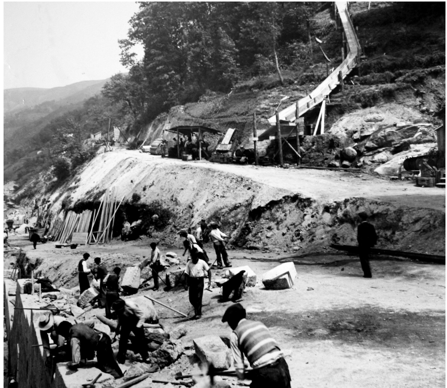
Fig. 234. Construção da estrada de acesso à central de Vila Nova, 1947.
