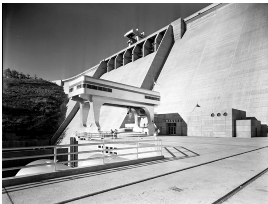
Fig. 131. Fotografia de Charles Krutch, Barragem de Hiwassee, Tennessee Valley Authority, s/d.
