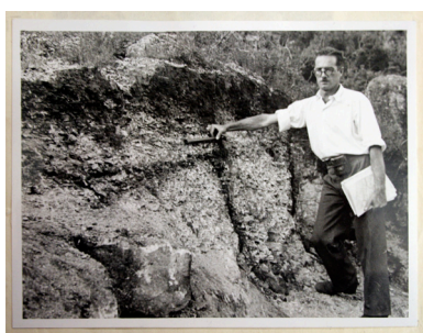
Fig. 121. Técnico do LNEC em observação dos terrenos da futura barragem de Salomonde, Maio de 1954.
