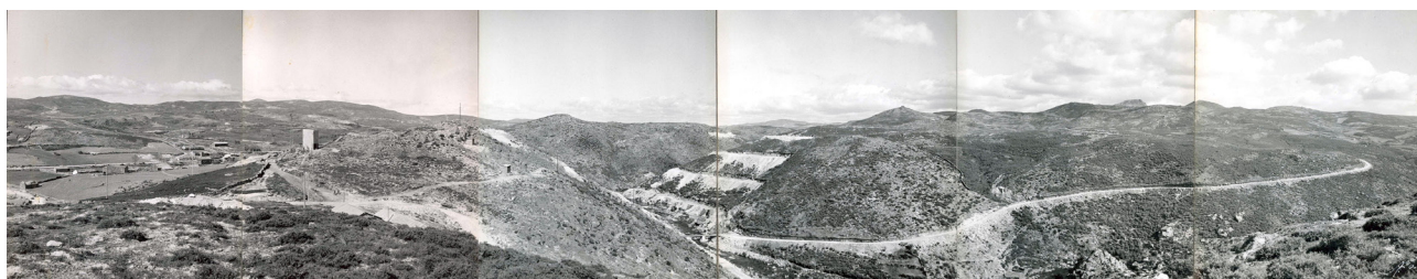
Fig. 99. Fotografia aérea do local do futuro estaleiro da barragem do Alto Rabagão e a nova estrada de acesso, Outubro de 1962.
