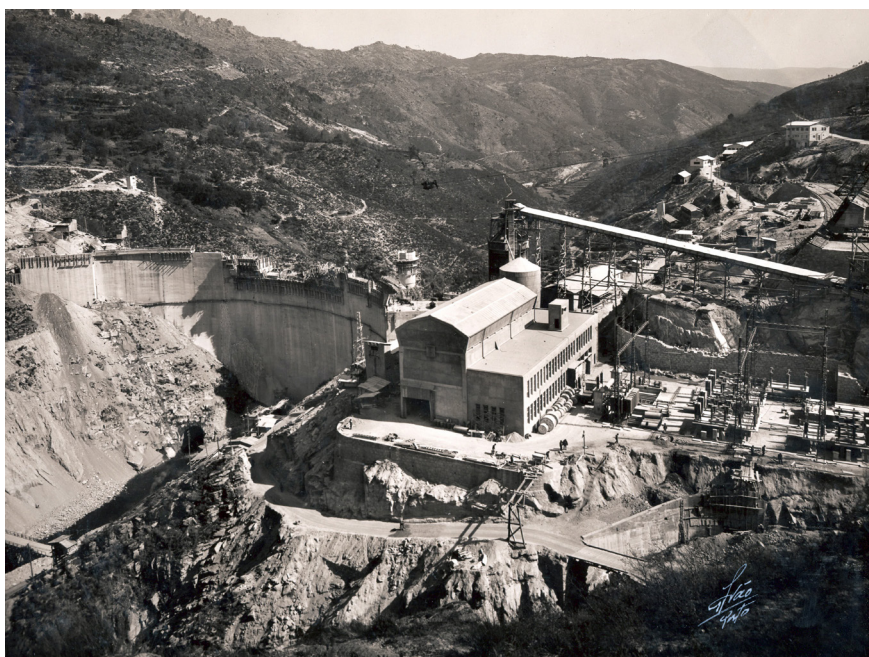
Fig. 59. Edifício da subestação e central da barragem de Salamonde, Janeiro de 1953.
