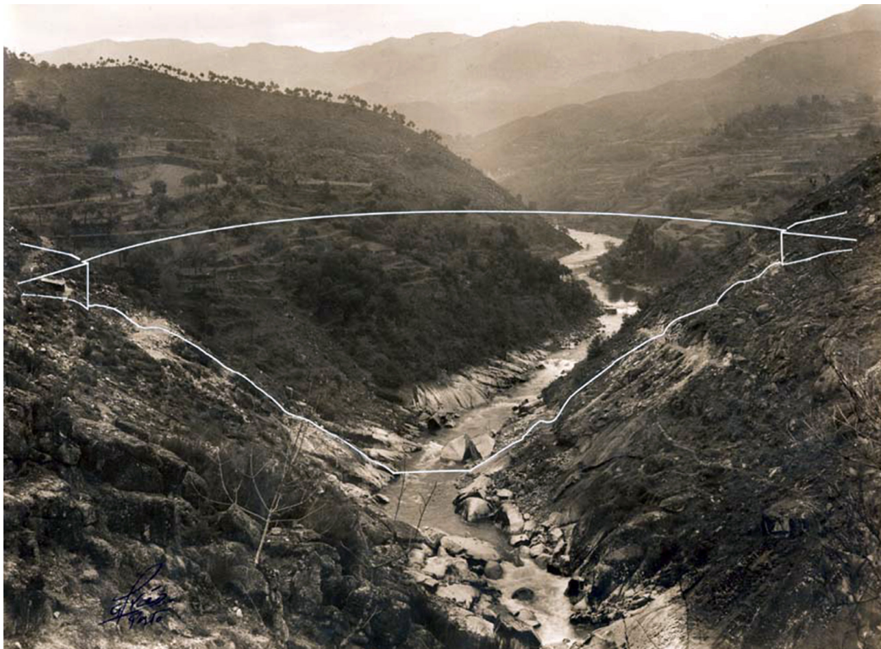
Fig. 71. Desenho de estudo de possível localização da barragem de Caniçada sobre fotografia, Agosto 1950.
