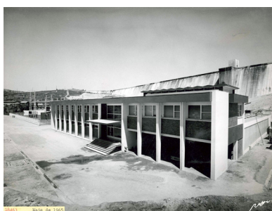
Fig. 106. Entrada e alçado principal do edifício de comando da barragem do Alto Rabagão, Maio de 1965.
