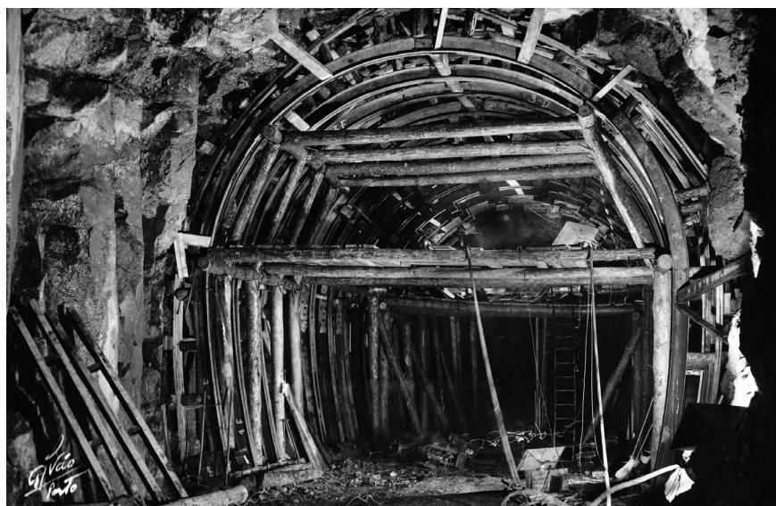
Fig. 82. Construção da central de caniçada, Outubro de 1953.
