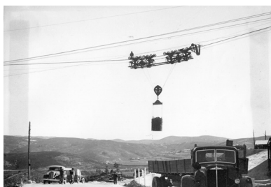
Fig. 15. Início da betonagem da Barragem de Venda Nova, Outubro de 1949.
