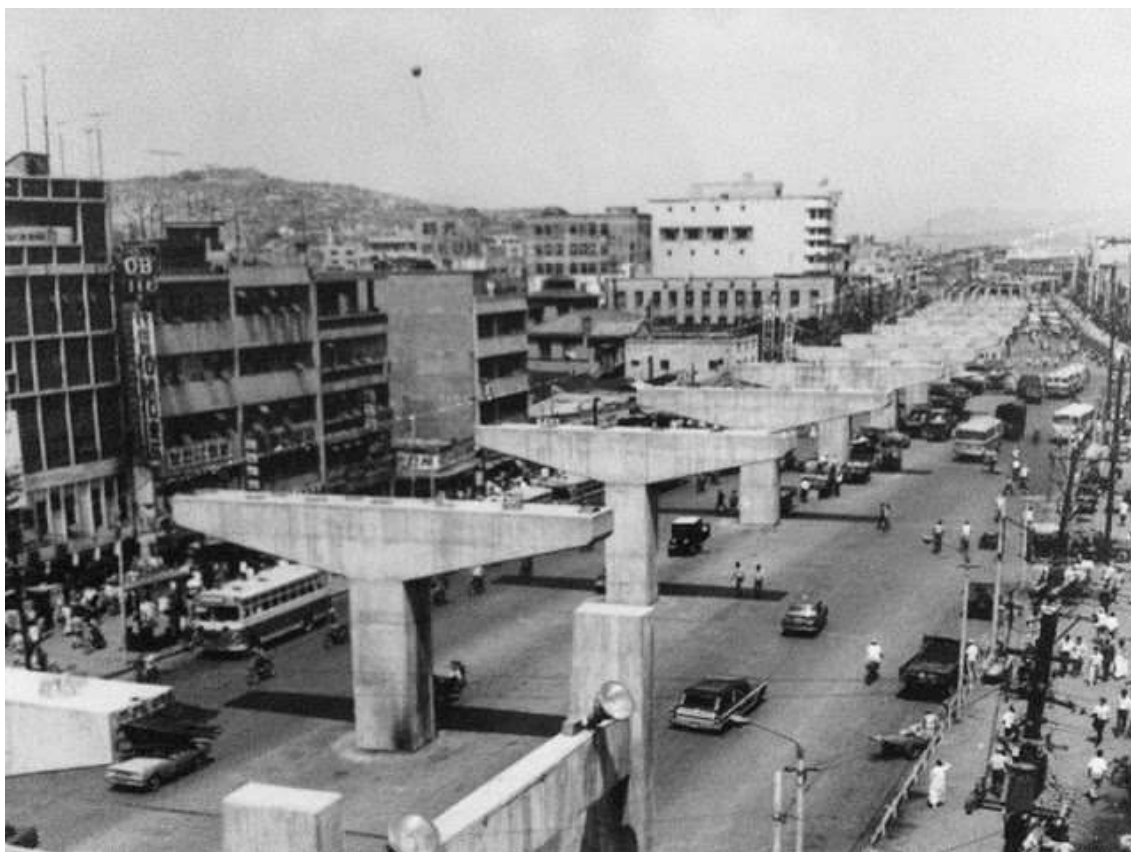
Figura 59 - Leito carrocável que encobriu o rio (fase de construção do viaduto)
