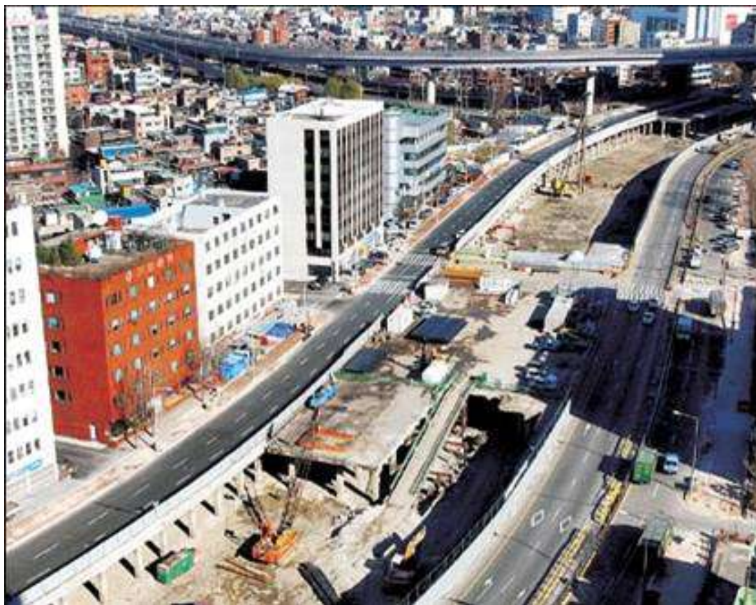
Figura 60 - Demolição da estrada em Julho de 2003
