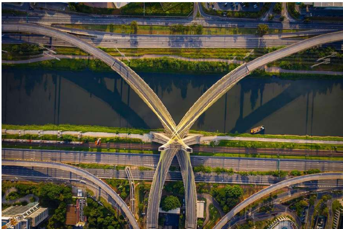
Figura 45 - Cruzamento da ponte estaiada sobre o rio Pinheiros
