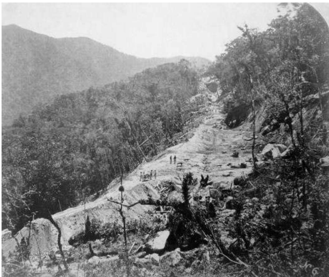
Figura 12 - Preparação do terreno na Serra do Mar para receber a linha férrea
