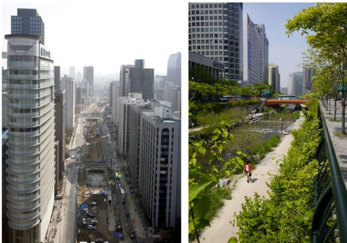
Figura 61 - Antes e depois das obras de restauração do córrego
