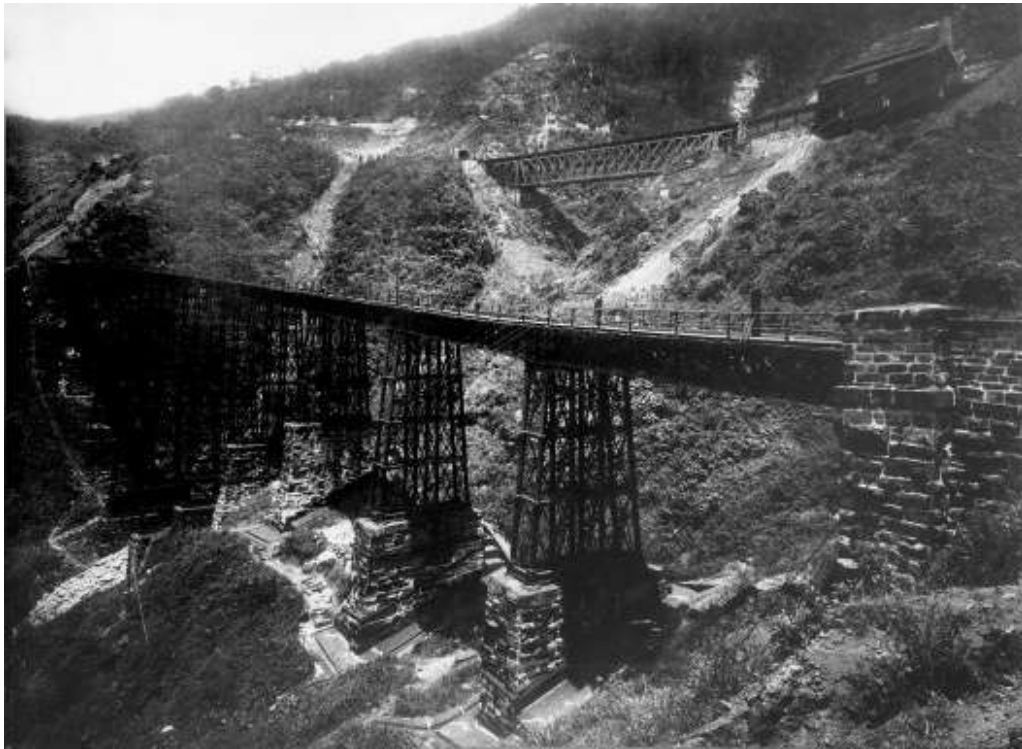
Figura 13 – Viadutos da Grota Funda
