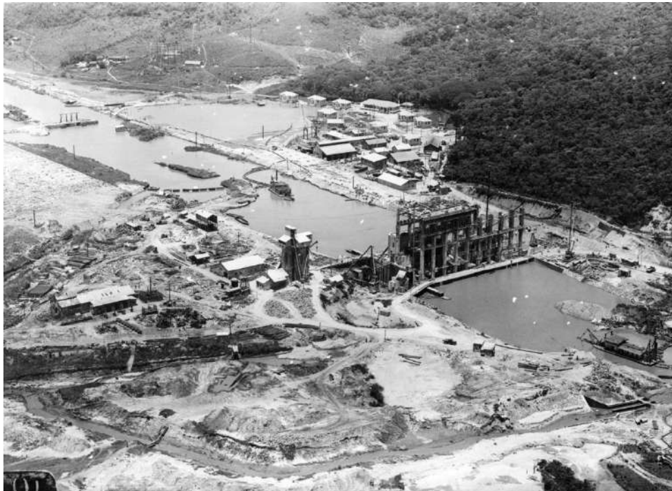
Figura 42 - Usina Elevatória de Traição, inaugurada em 1940
