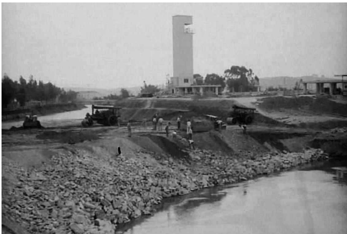
Figura 32 - Construção da Ponte das Bandeiras em 1941
