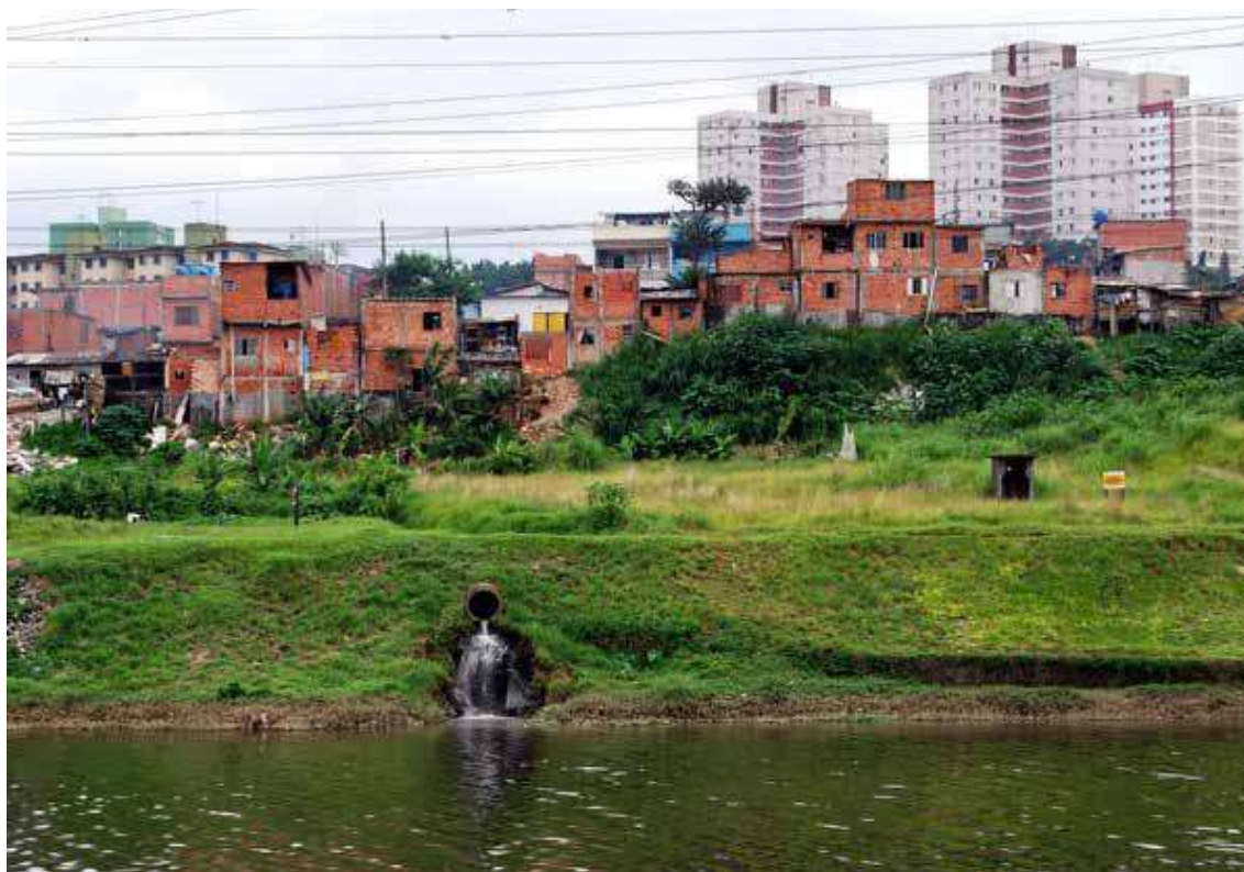
Figura 24 - Ocupações irregulares no Rio Pinheiros, altura da ponte Jurubatuba
