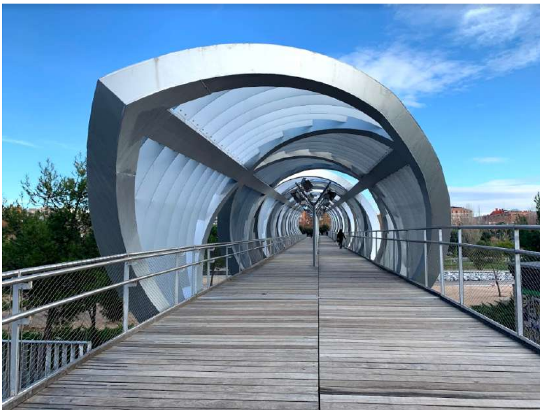
Figura 68 - Vista interna Ponte de Arganzuela
