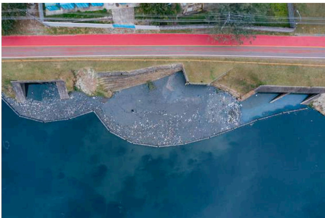
Figura 49 - Lançamento de esgoto no rio Pinheiros
