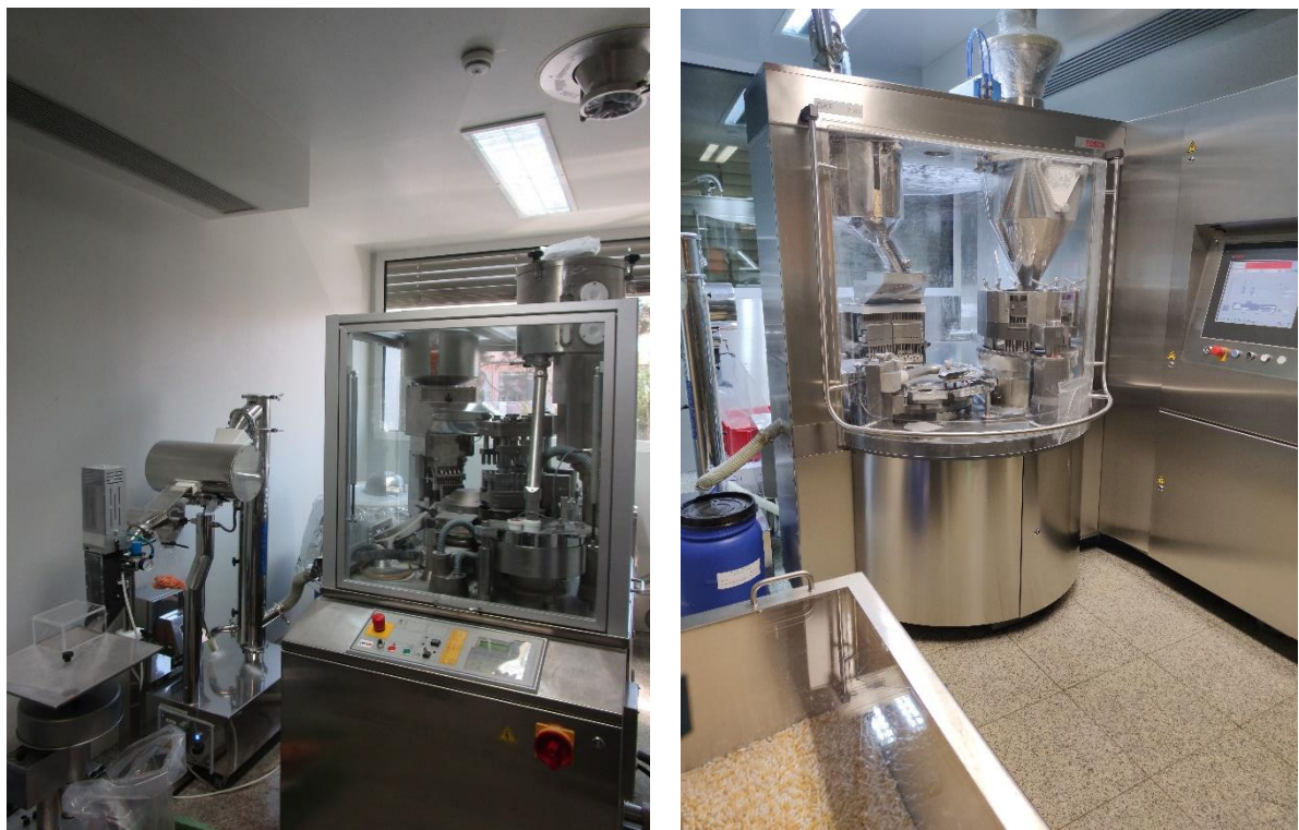
Figura 8: Sala de enchimento de cápsulas ZANASI PLUS 85E E BOSCH GKF 2500.
