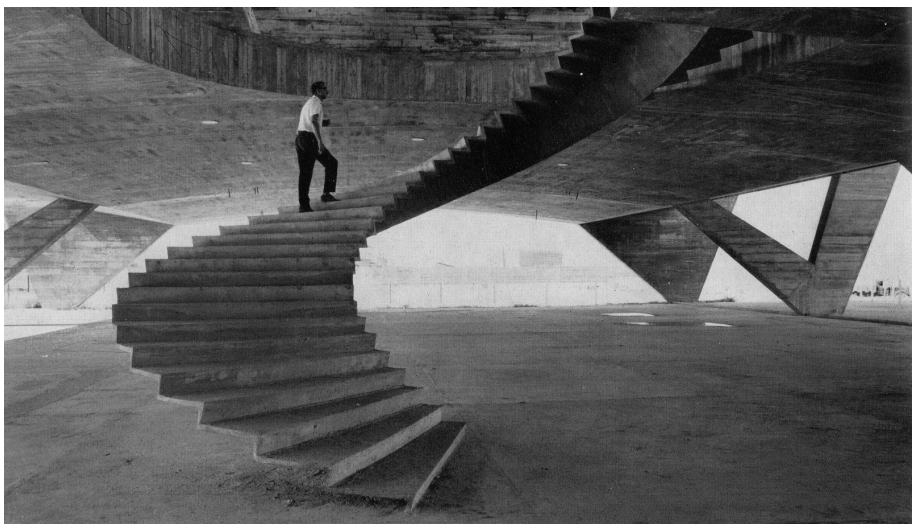
Fig. 78 Escadaria no Museu de Arte Moderna do Rio de Janeiro | Affonso Reidy.
