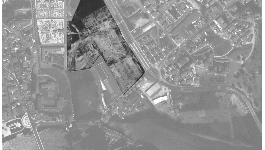
Fig. 10 Demolição da fábrica têxtil Narfil liberta os terrenos para posterior construção. 4 de Julho de 2010
