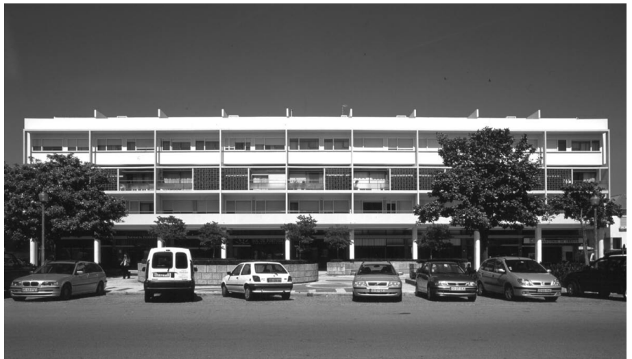
Fig. 34 Edifício de habitação e comércio na praça D. Afonso V, Porto. Francisco Pereira da Costa.
