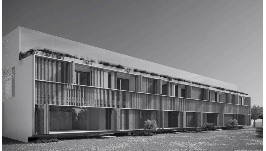
Fig. 72 Edifício de habitação Aljubarrota 72 | Correia Ragazzi Arquitetos.
