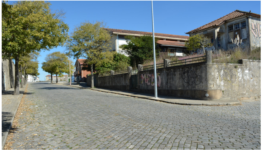
Fig.15 Avenida Figueiredo Faria Abandono completo das construções. 8 de Outubro de 2020.
