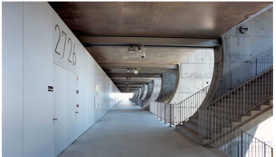
Fig. 81 Galeria de distribuição no Estádio Municipal de Braga | Eduardo Souto de Moura.
