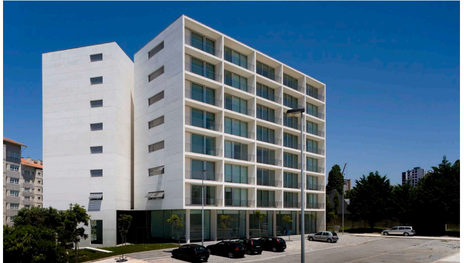
Fig.32 Edifício de habitação e comércio 'Casas Brancas', Porto. Adalberto Dias.
