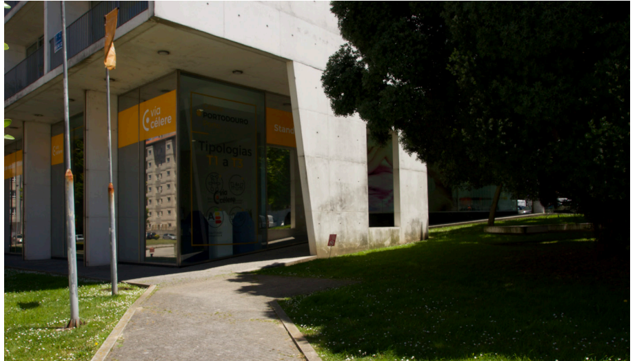
Fig.37 Estrutura oculta a entrada. Vista a partir da rua do Orfeão do Porto. 15 de Junho de 2020.
