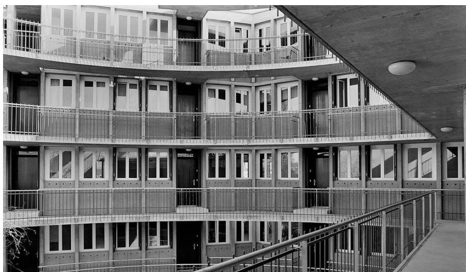
Fig. 50 Vista para as galerias de distribuição a partir da varanda comum.
