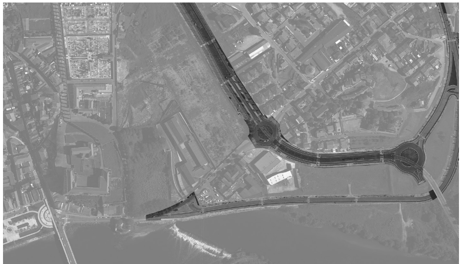
Fig. 11 Abertura da Avenida do Ave | Conclusão das vias paralelas à linha de metro. 22 de Julho de 2012
