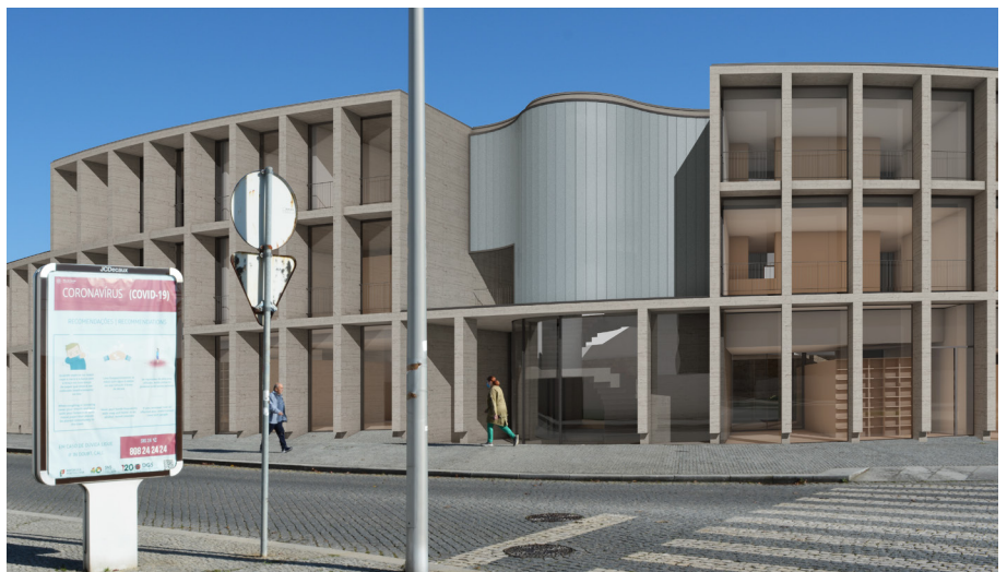
Fig. 104 Vista a partir da Avenida Bernardino Machado.
