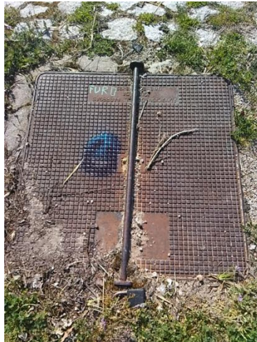
Figura 15: Furo, na freguesia de Tronco, em 25/04/2018
