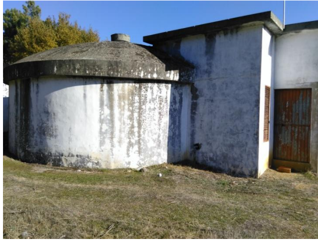
Figura 7:Reservatório, na freguesia de Vilas Boas, em 05/12/2017
