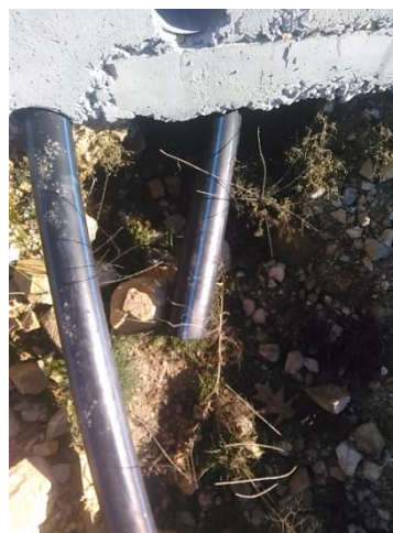
Figura 14: Descarga de Fundo, no concelho de Chaves, em 11/01/2019
