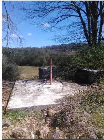
Figura 11: Célula de um reservatório, na freguesia de Moreiras, em 12/04/2019
