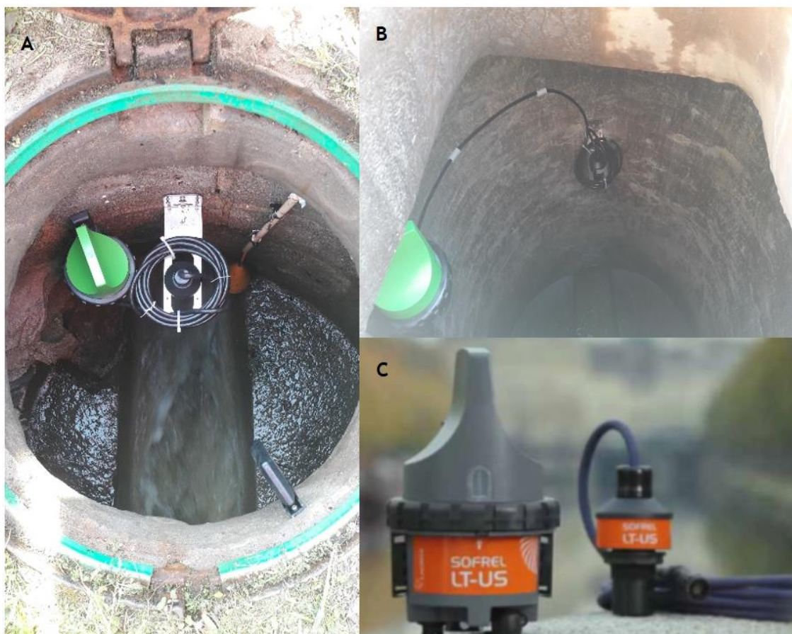
Figura 2.23. (A) e (B) Instalação de caudalímetro LT-US, (C) Caudalímetro LT-US
