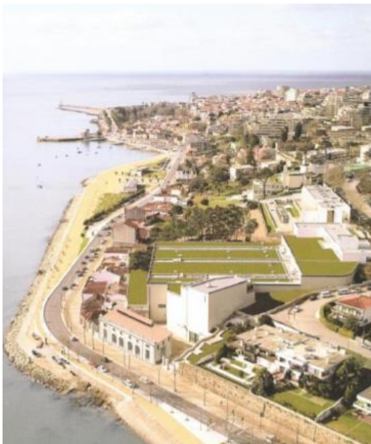
Figura 4.7. Vista aérea da ETAR de Sobreiras. Retirado de (AQUALITRANS, 2019)
