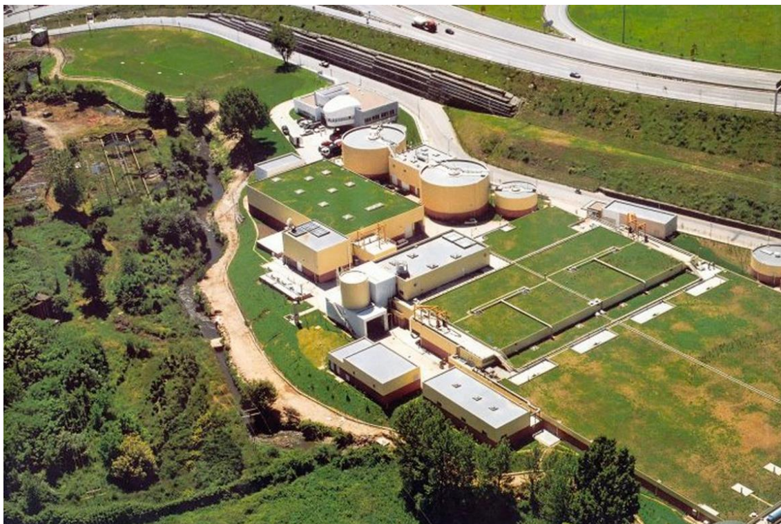
Figura 4.6. Vista aérea da ETAR do Freixo. Retirado de (Porto., 2017)
