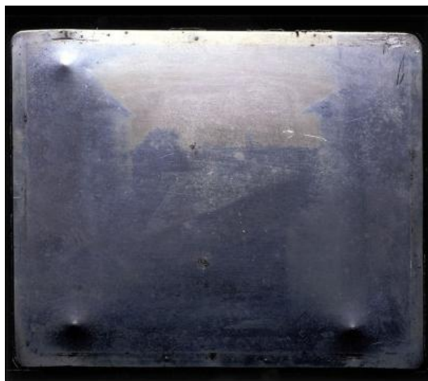
Figura 1 - Vista de Le Gras.
