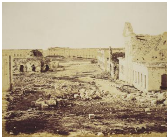
Figura 7 - Construções em ruína em Sebastopol, James Robertson, 1855.
