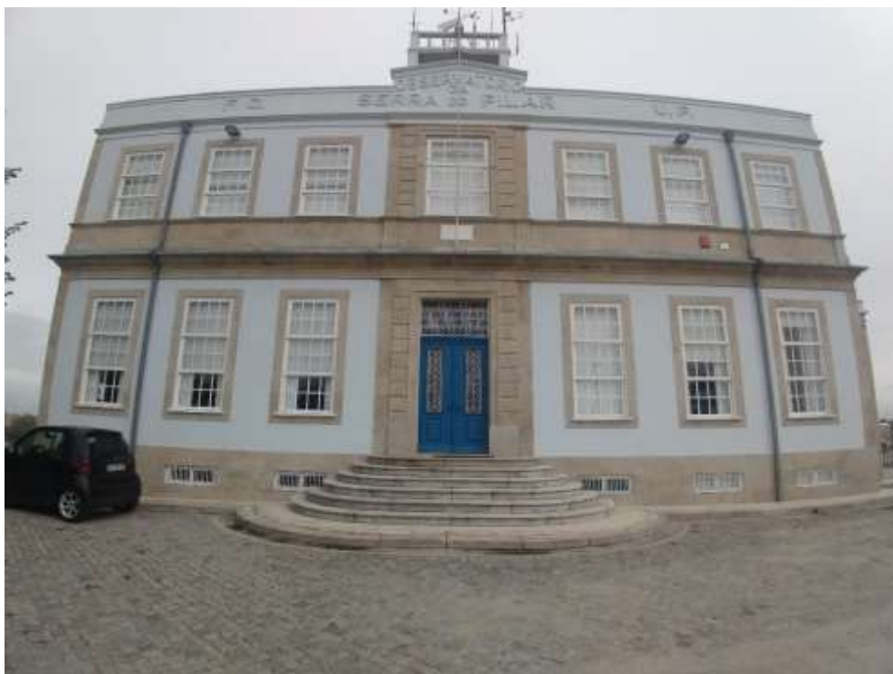
Figura 15- Fachada do edifício principal.
