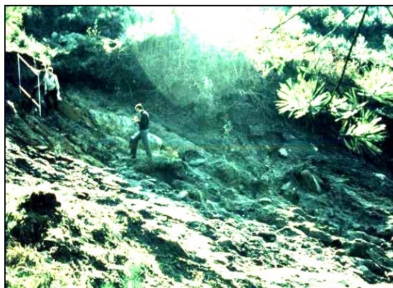
Fot. C2-20: Cicatriz do fluxo de detritos de Cavez, vista geral.
