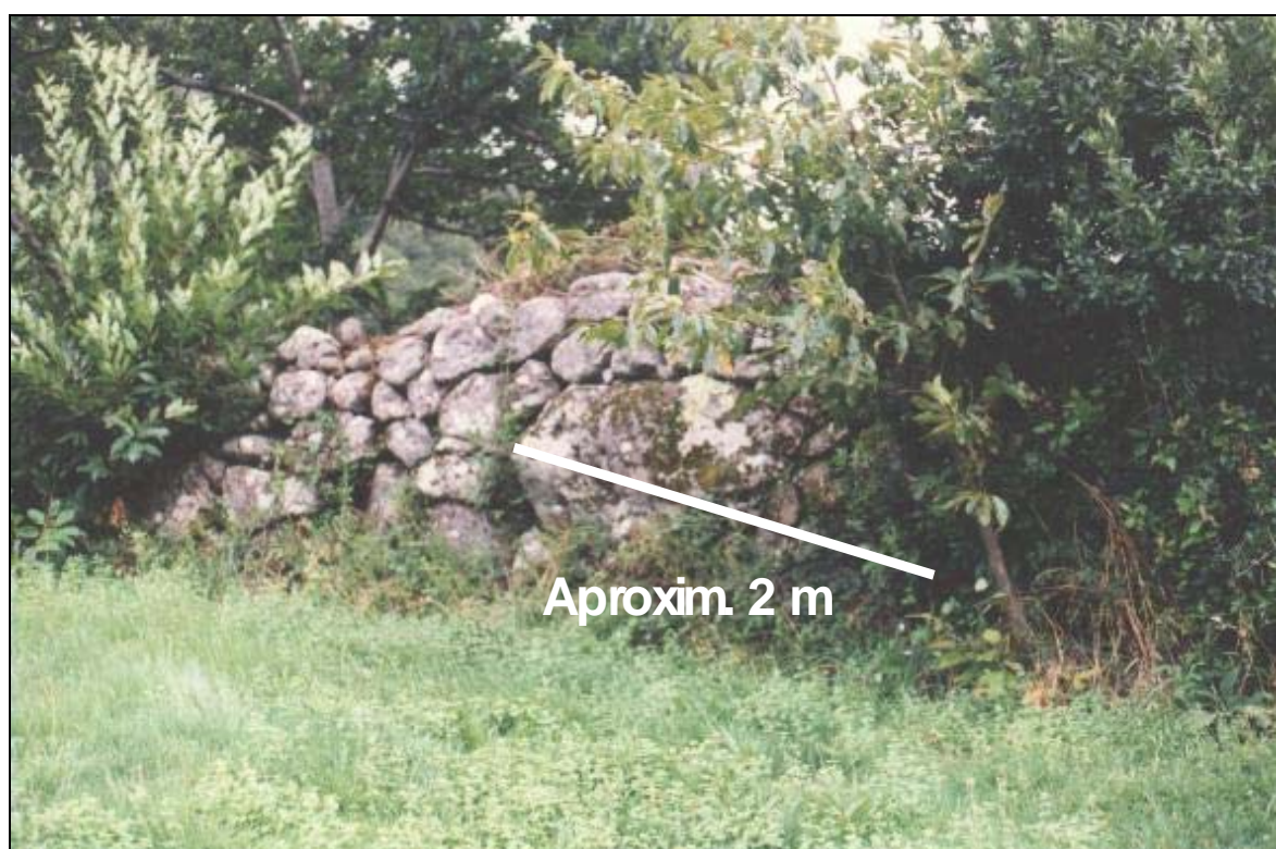
Fot. C2-11: Muro construído com blocos e calhaus recolhidos da superfície do depósito resultante do fluxo de detritos. O bloco assinalado tem cerca de 2 m de diâmetro maior.
