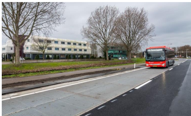
Figura 1 - Sistema aplicado numa via com tráfego de pesados nos Países Baixos desenvolvido pela SolaRoad- SolaRoad
