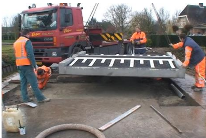
Figura 10 - Instalação do sistema Flex-Drempel - Total Technical Solutions
