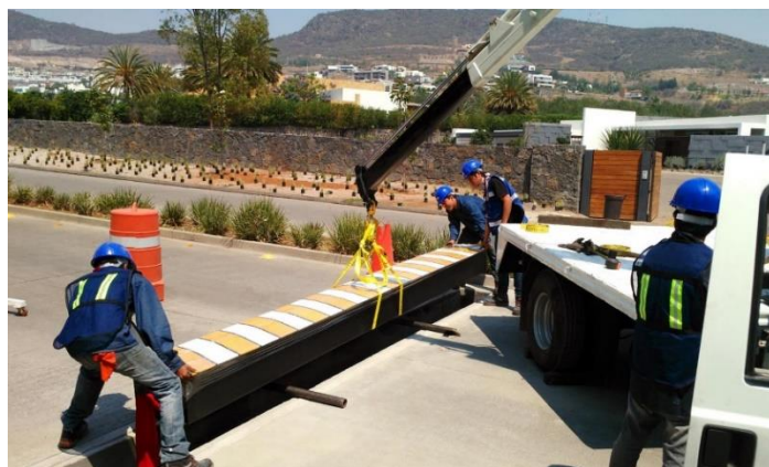
Figura 13 - Instalação do Tope Inteligente num ambiente relevante, antes duma passeadeira, no México- Inteligencia Vial
