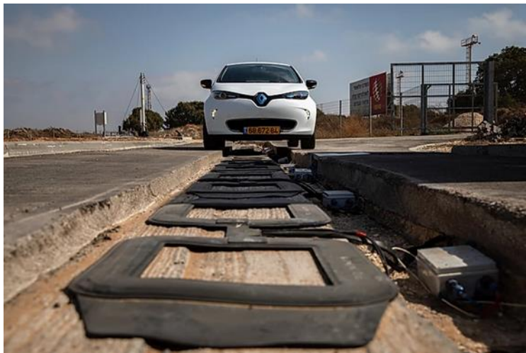
Figura 9 - Bobinas, criadas pela Electreon , prontas a serem revestidas pela camada superficial do pavimento- Electreon
