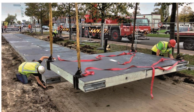
Figura 2 - Pormenor da instalação do protótipo da SolaRoad- SolaRoad
