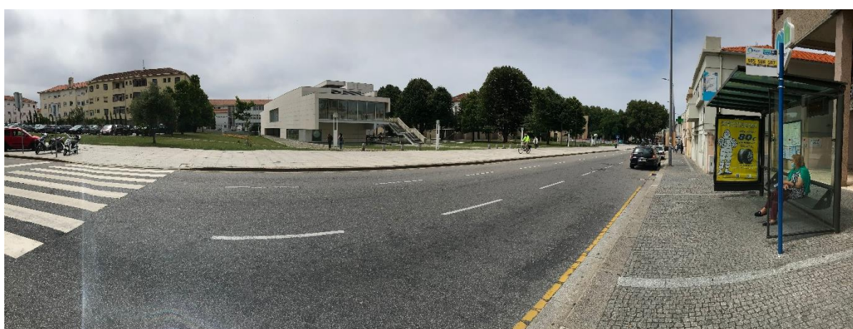
Figura 44 - Local de instalação do projeto piloto em Matosinhos, no sentido do trânsito, depois da primeira passadeira
