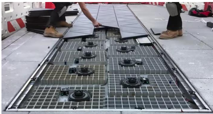
Figura 5 - Processo de instalação do sistema Pavegen num passeio em Londres- Pavegen
