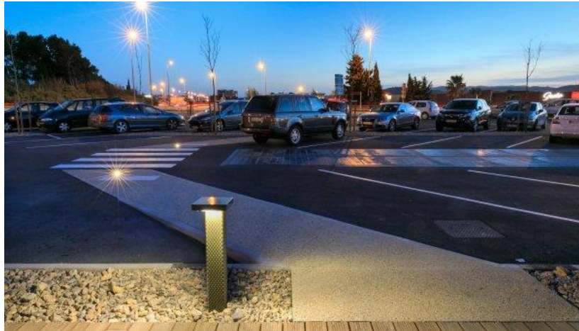
Figura 4 - Prototipagem da Wattway instalado num parque de estacionamento exterior na França- Wattway
