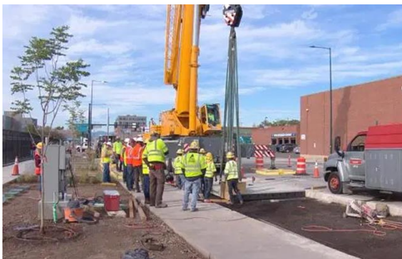
Figura 8 - Pormenor na colocação de um dos módulos Smart Pavement em Denver, Colorado- Integrated Roadways
