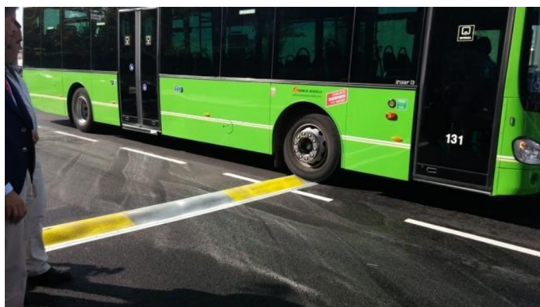
Figura 11 - Momento em que o BIV atua em presença de veículos que respeitam o limite de velocidade- Badennova
