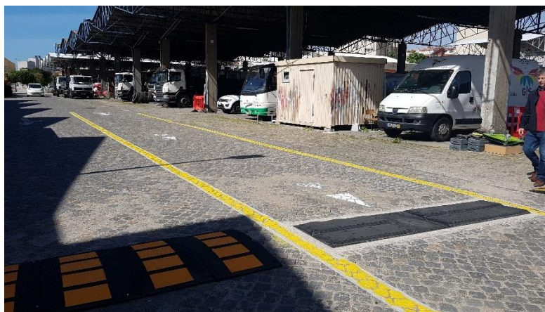
Figura 29 - Protótipo da Pavnext instalado numa via interna na CMM
