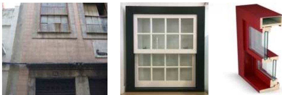
Figura 3.6 – Foto atual do estudo de caso; Novo caixilho em madeira: pormenor caixilharia em alumínio de janela tipo guilhotina (Retirado de [19]).
