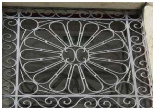
Figura 2.40 – Proteção da bandeira em vidro existente sobre a porta.
