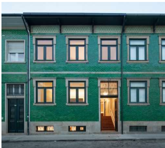
Figura 3.21 – Fachada principal do edifício (Retirado de [20]).
