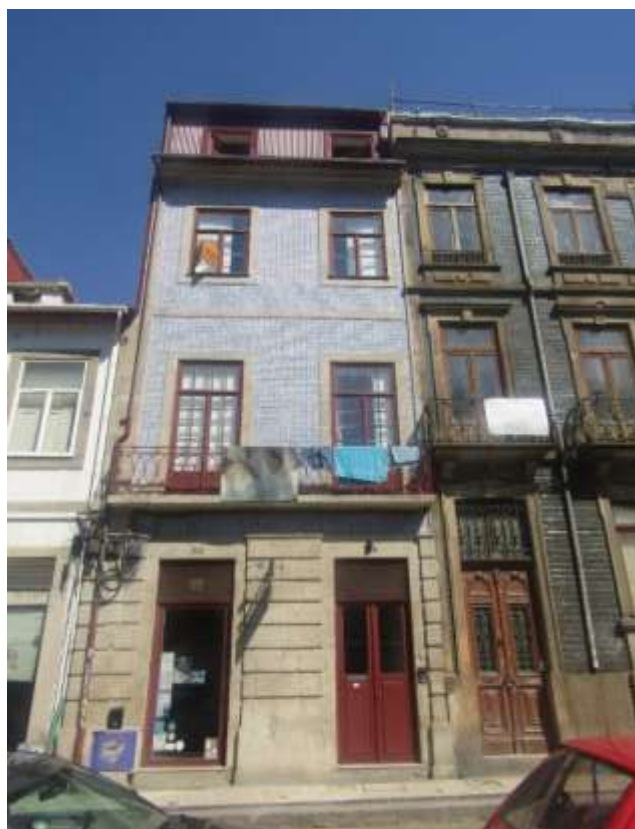
Figura 4.7– Fachada principal Casa da Cedofeita.
