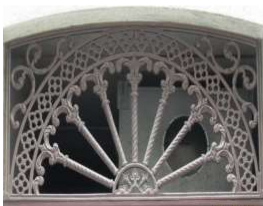
Figura 2.39 – Proteção da bandeira da porta principal – Ferro fundido pintado.
