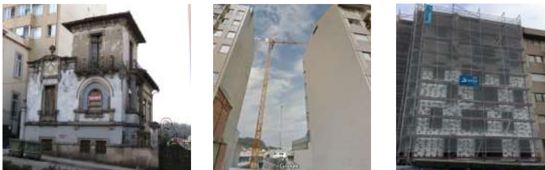
Figura 3.8 – Exemplo de demolição completa de edifício e construção de habitação coletiva – Rua Pinto Bessa, Porto.
