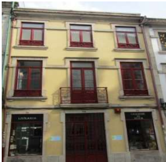
Figura 2.22 – Fachada com acabamento em reboco pintado.
