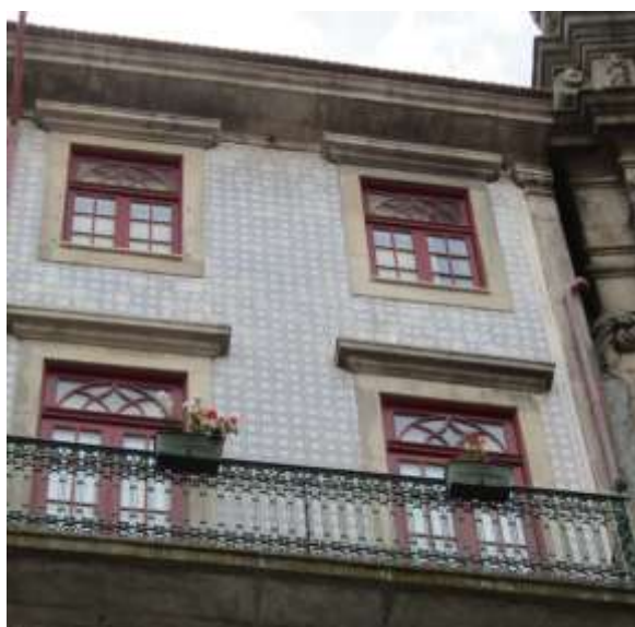
Figura 2.21 – Fachada com acabamento em material cerâmico.
