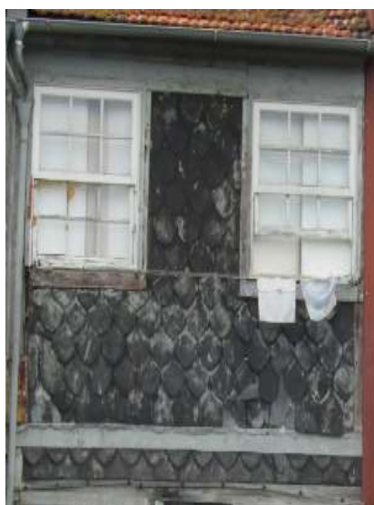
Figura 2.35 – Fachada revestida a soletos de ardósia.
