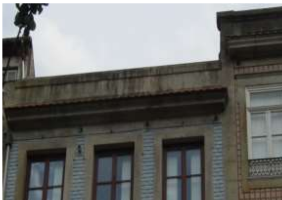
Figura 2.10 – Casa Burguesa do Porto apresentando vários elementos em pedra de granito (cornija, platibanda, cunhais e lancis).
