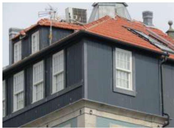
Figura 2.33 – Último piso com acabamento em chapa zincada, incluindo no mirante.
