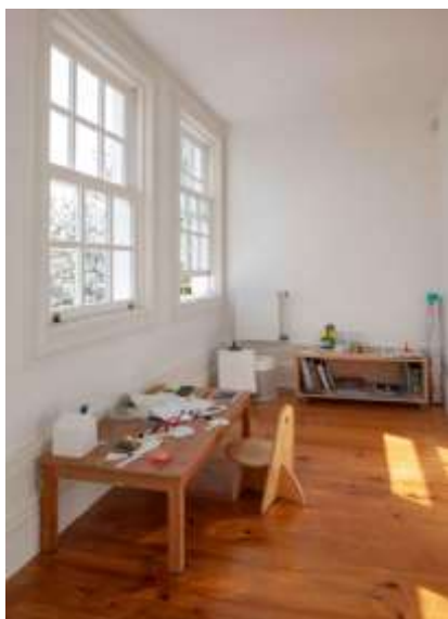
Figura 3.12 – Vista pelo lado interior das caixilharias das janelas (Retirado de [20]).
