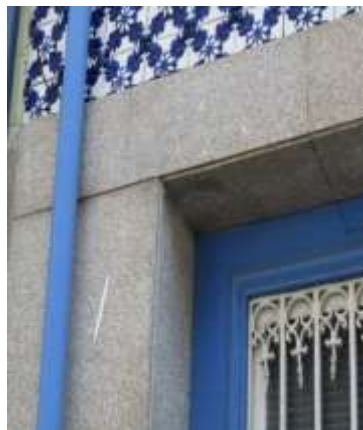
Figura 4.6 – Pormenor da forra em pedra de granito nas orlas dos vãos do rés-do-chão.
