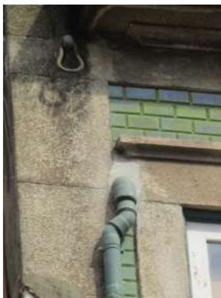
Figura 5.12 – Tubo de queda que recolhe águas no algeroz e depois as leva até ao arruamento, pelo exterior.
