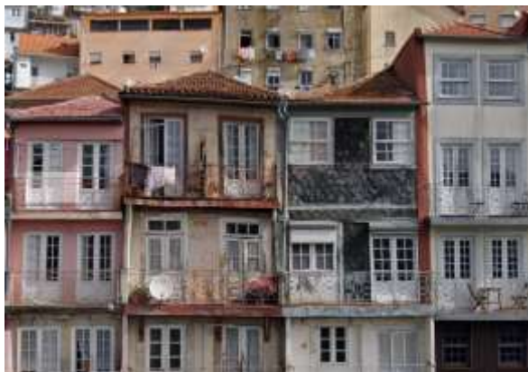
Figura 2.2 – Fachadas de casas com acabamentos menos nobres.
