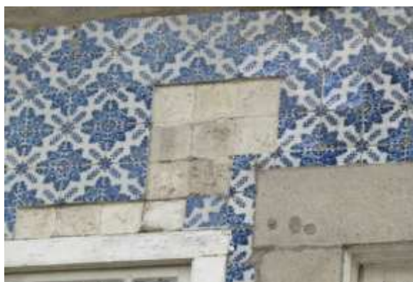
Figura 5.4 – Destacamento de acabamento com mosaico cerâmico.
