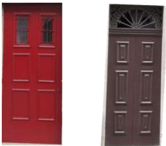
Figura 2.45 – Foto de portas exteriores com almofadas – detalhe.
