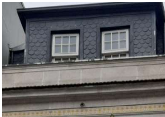
Figura 2.50 – Cornija e platibanda em pedra de granito.
