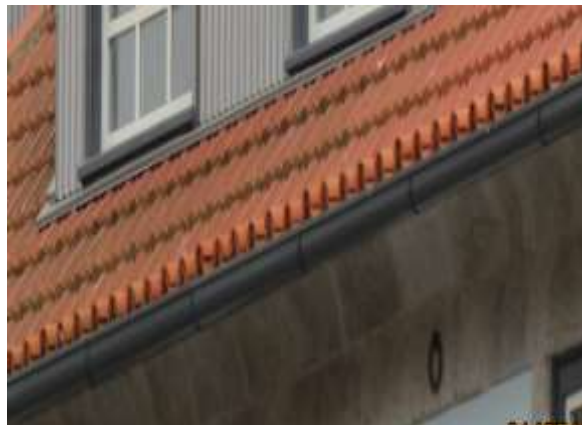
Figura 2.48 – Beiral com caleira exterior que recolhe as águas e encaminha para tubos de queda, solução original.
