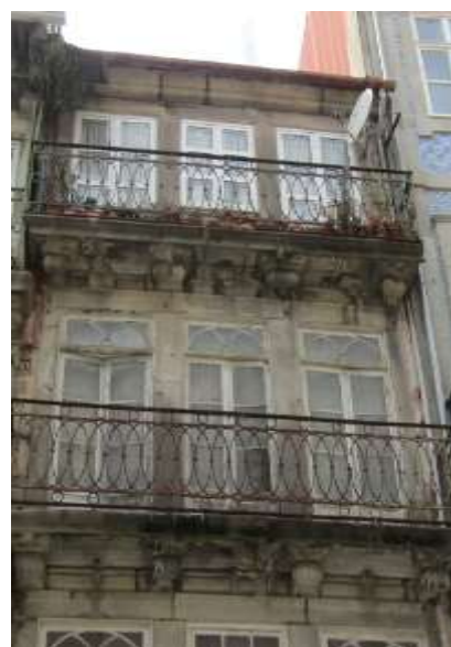
Figura 2.25 – Fachada integralmente realizada em pedra de granito.
