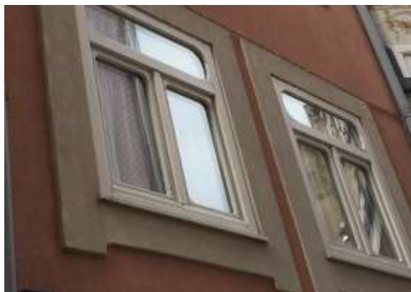
Figura 4.3 – Pormenor das orlas dos vãos em argamassa pintada.
