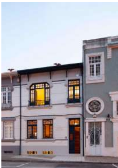
Figura 3.10 – Fachada principal do edifício Antonio Patrício (Retirado de [20]).
