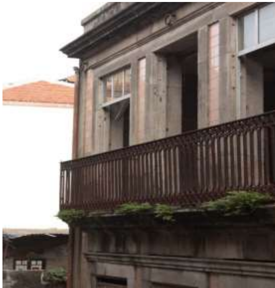
Figura 7.8 – Pormenor gradeamento em ferro.
