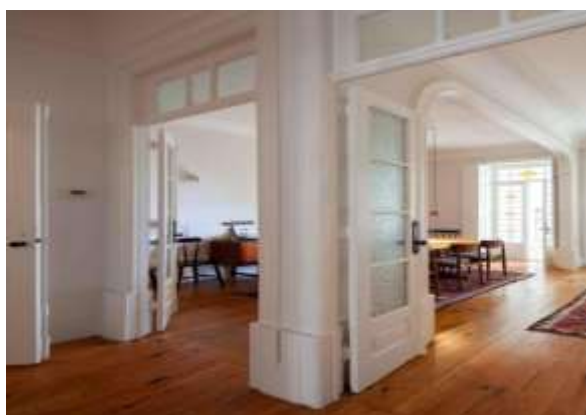
Figura 3.18 – Manutenção de portas em madeiras esmaltada de cor branca incluindo vidros na parte superior da bandeira. Manutenção de soalho (Retirado de [20]).
