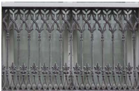
Figura 2.41 – Proteção da bandeira da porta principal – pormenor.
