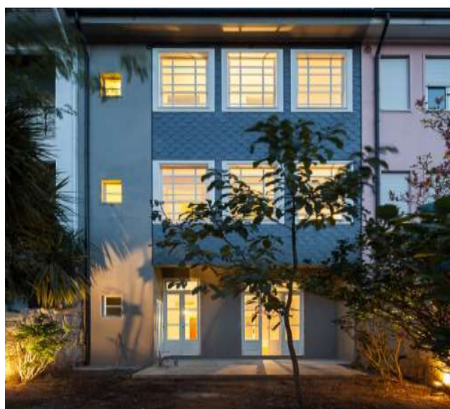
Figura 3.22 – Fachada traseira do edifício (Retirado de [20]).
