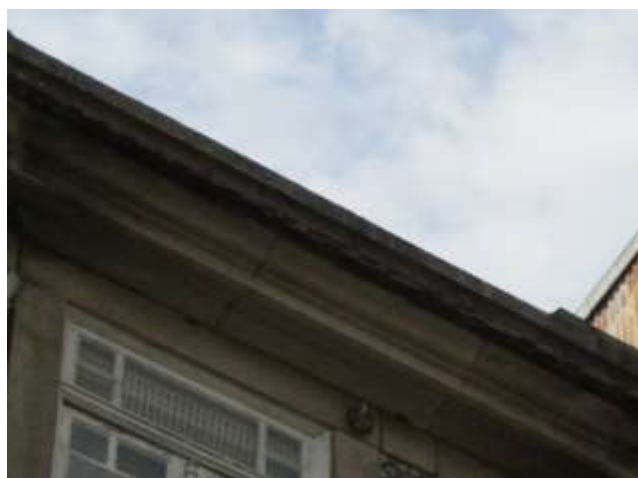
Figura 2.46 – Cornija em pedra de granito.
