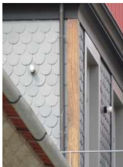
Figura 2.36 – Edifício recentemente reabilitado mantendo o acabamento de fachada do último piso em soletos de ardósia.
