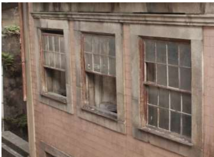
Figura 7.6 – Caixilharia em madeira – vista global.
