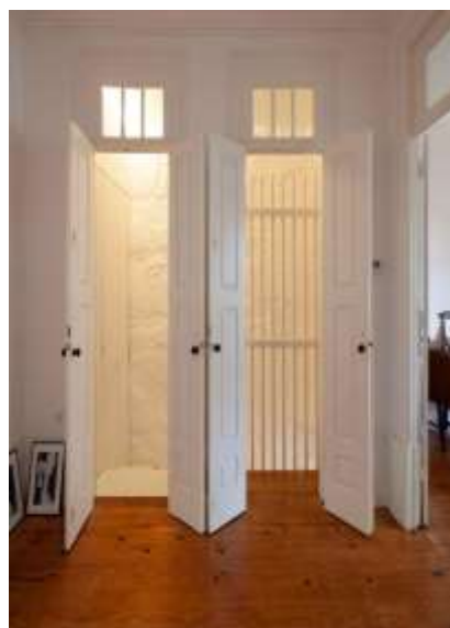
Figura 3.13 – Manutenção de portas em madeiras esmaltada de cor branca incluindo vidros na parte superior da Bandeira (Retirado de [20]).
