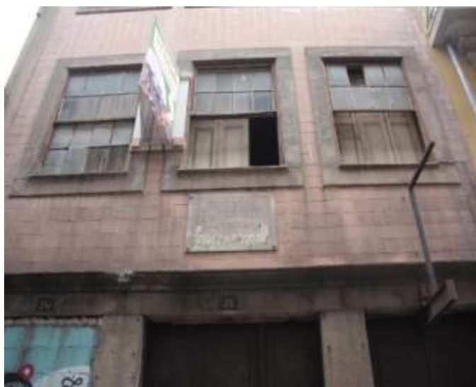
Figura 7.3 – Fachada principal do Edifício Ponte Nova.
