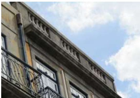
Figura 2.9 – Casa Burguesa do Porto apresentando vários elementos em granito (cornija, platibanda, lancis e balaústres).
