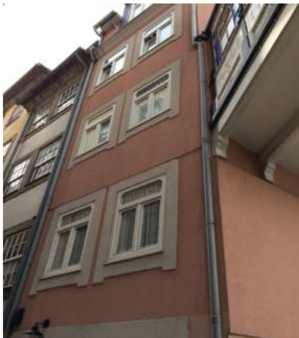
Figura 4.1 – Fachada do edifício 1872 River House.
