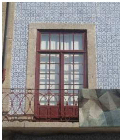
Figura 4.9 – Pormenor da janela com a portada interior em madeira esmaltada de cor branca.
