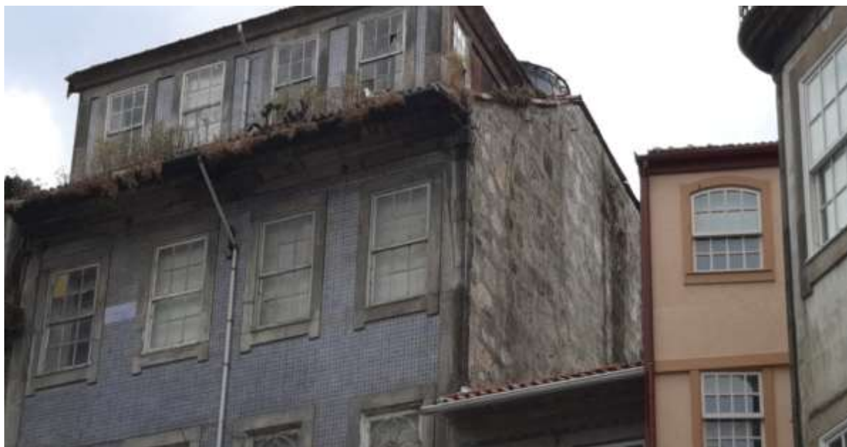
Figura 2.54 – Empena cega em pedra não revestida.
