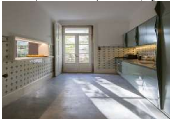
Figura 3.26 – Material cerâmico aplicado como lambrim na cozinha (Retirado de [20]).
