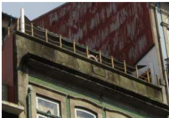
Figura 2.49 – Cornija em pedra de granito.
