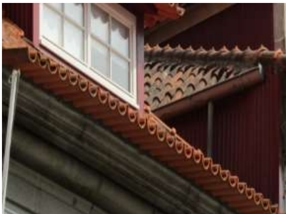
Figura 2.47 – Beiral em telha de fabrico específico para beiral.
