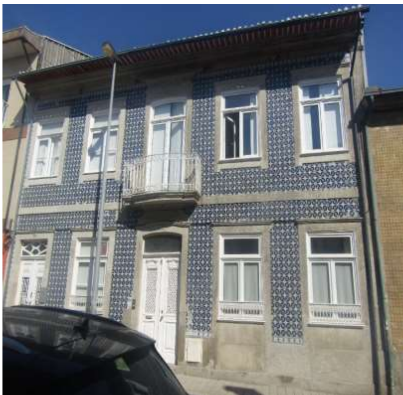
Figura 4.13 – Fachada principal das casas “Pinheiro Manso”.
