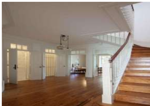
Figura 3.17 – Manutenção de pisos em soalho de madeira e tetos estucados em gesso com as respectivas molduras (Retirado de [20]).
