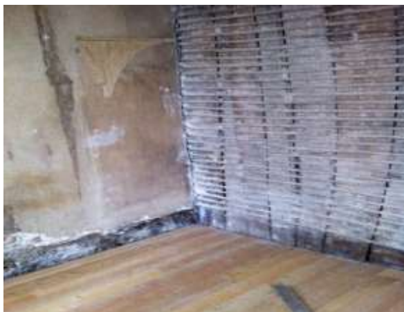
Figura 2.26 – Parede interior em tabique simples.
