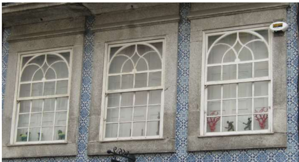
Figura 5.6 – Foto representando janelas tipo guilhotina, em bom estado.
