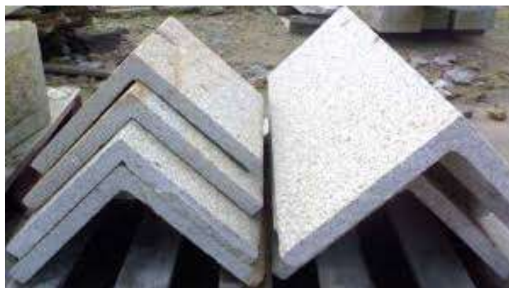
Figura 6.8 – Exemplo de pedra para cunhais.
