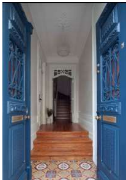
Figura 3.11 – Porta principal em madeira mantendo elementos em ferro esmaltado de cor azul (Retirado de [20]).
