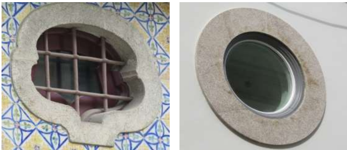
Figura 2.38 – Óculos em pedra granítica.
