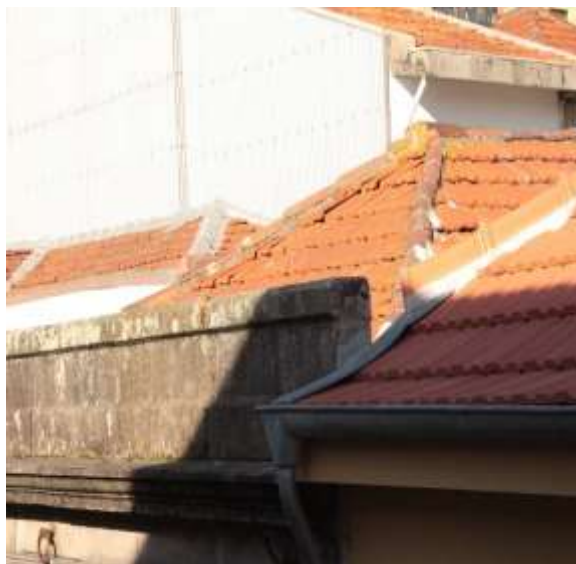
Figura 7.7 – Pormenor da platibanda e cobertura.
