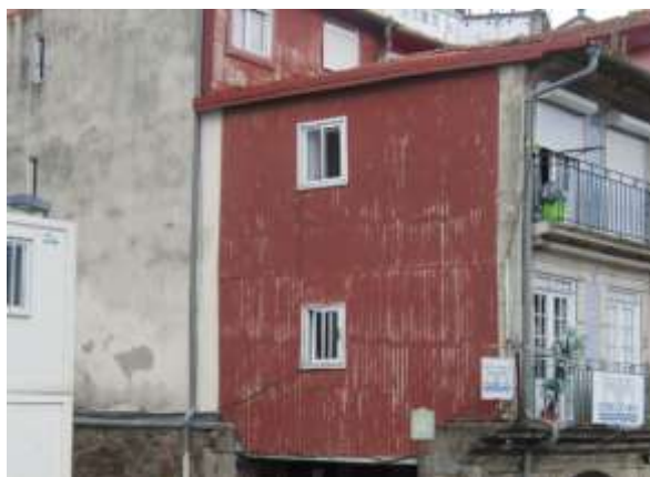
Figura 2.32 – Empena com acabamento em chapa zincada.
